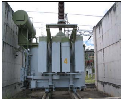
Figura 6. Transformadores de la Subestación Bucaramanga
