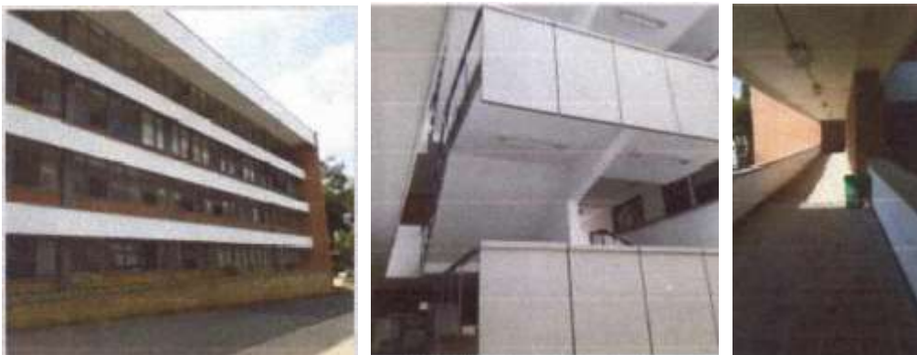
Figura 7. Edificio Camilo Torres año, 2019
