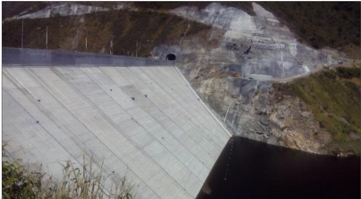
Figura 1. Vista lateral de la presa en etapa de llenado, (Tomada 15/12/2015)
