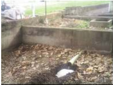
Figura 40. Salida del efluente del filtro
