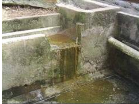
Figura 8. Cribado entrada al sedimentador flujo forzado
