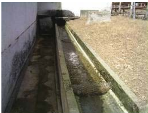
Figura 7. Cribado en sistema de conducción.
