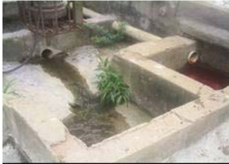
Figura 13. Entrada al tanque de mezclado
