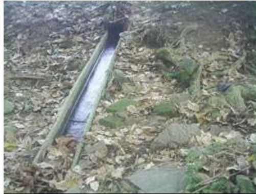
Figura 29. Taponamiento del canal de Entrega
