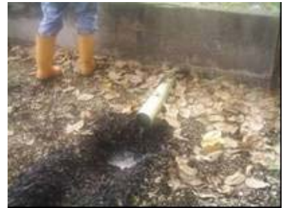
Figura 41. Efluente filtro anaerobio
