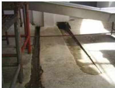
Figura 4. Canales de conducción del agua de lavado (sanguinolenta)
