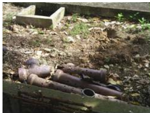
Figura 26. Tubería perforada en la superficie
