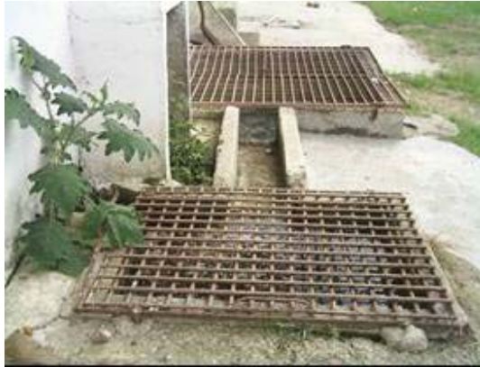
Figura 11. Trampa de grasa, salida
