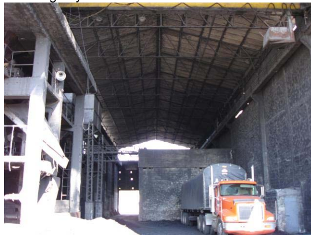
Fotografía 3 Sección de descargue y molienda de carbón.
