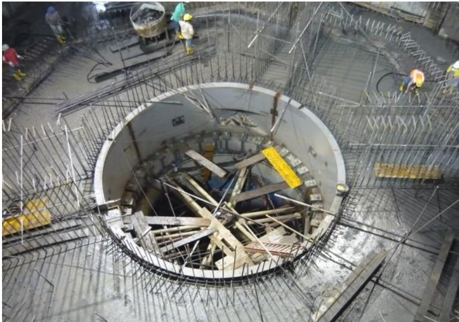
FIGURA 6. Fundición de la cámara espiral.
