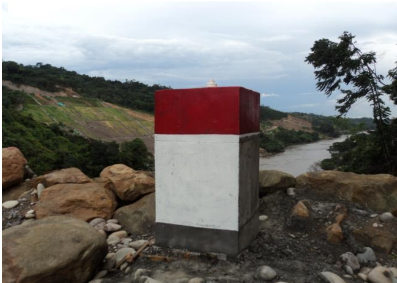
Mojón de control ubicado en los llenos de la presa.
