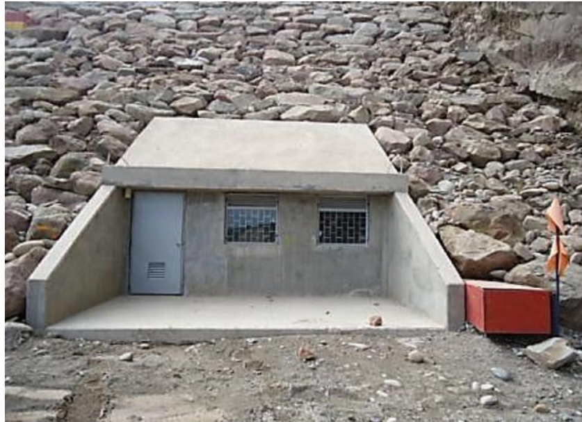
FIGURA 16. Exterior de la caseta de instrumentación CS-4.
