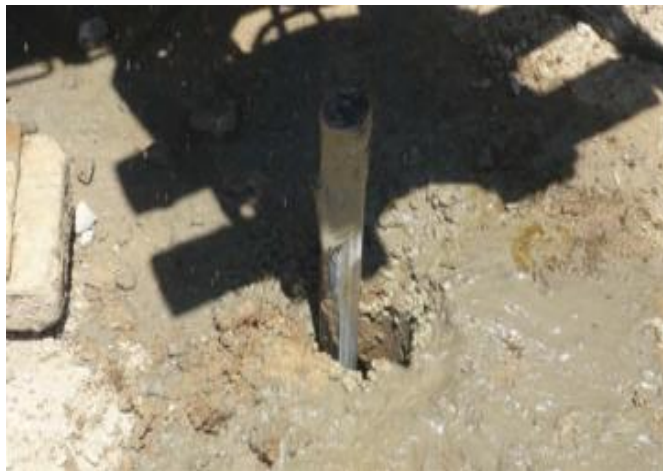
Tubería introducida en el sondeo.
