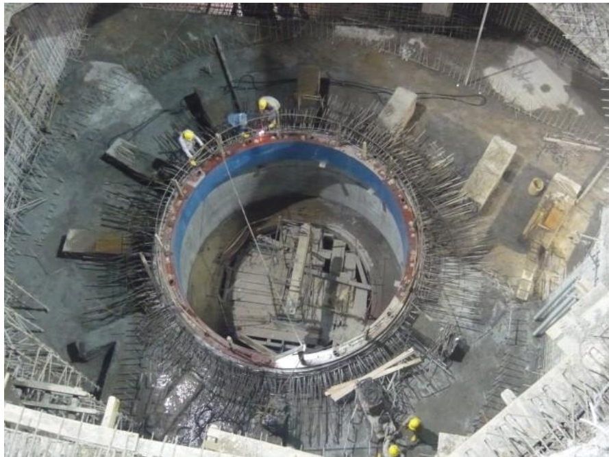
FIGURA 3. Instalación del anillo cuatripartido de la cámara espiral.
