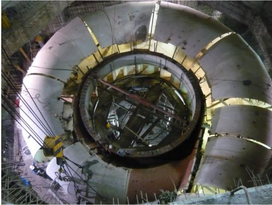
FIGURA 4. Instalación de las piezas que componen la cámara espiral.
