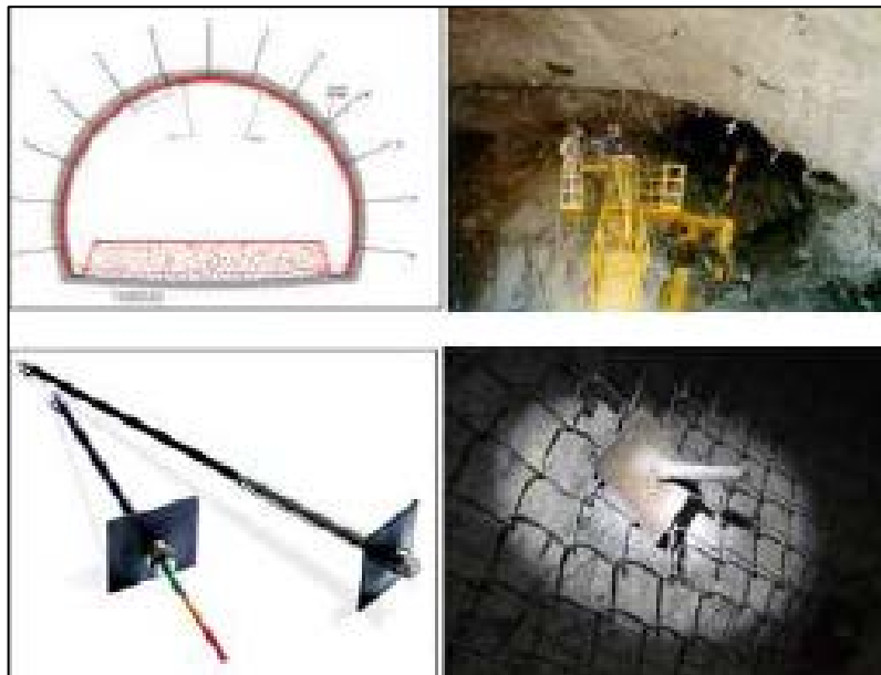
Figura 19. Bulones, disposición perimetral con orientación radial.
