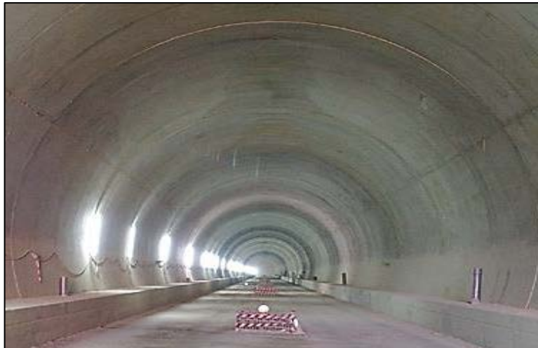
Figura 17. Sostenimiento de un túnel con hormigón proyectado.
