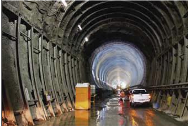
Figura 18. Arcos metálicos o costillares.
