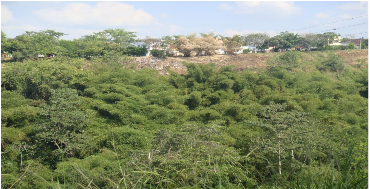
Fotografía 4. Vista del Talud Barrio Don Bosco
