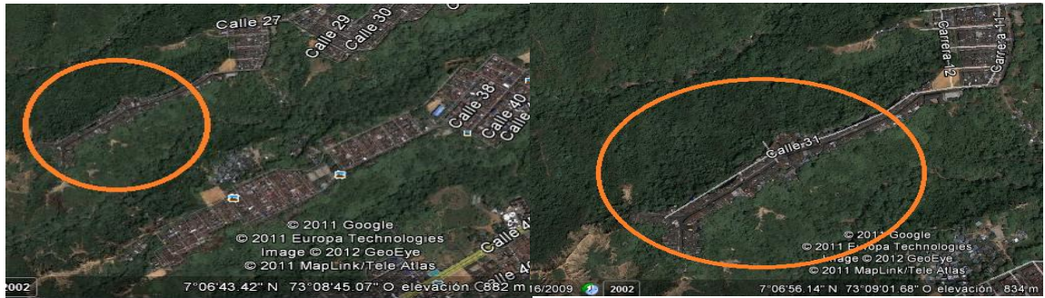
Figura 2. Localización del talud.
