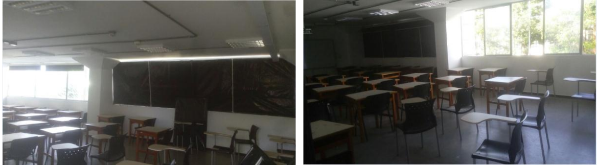
a. Ventana suroccidente cubierta
