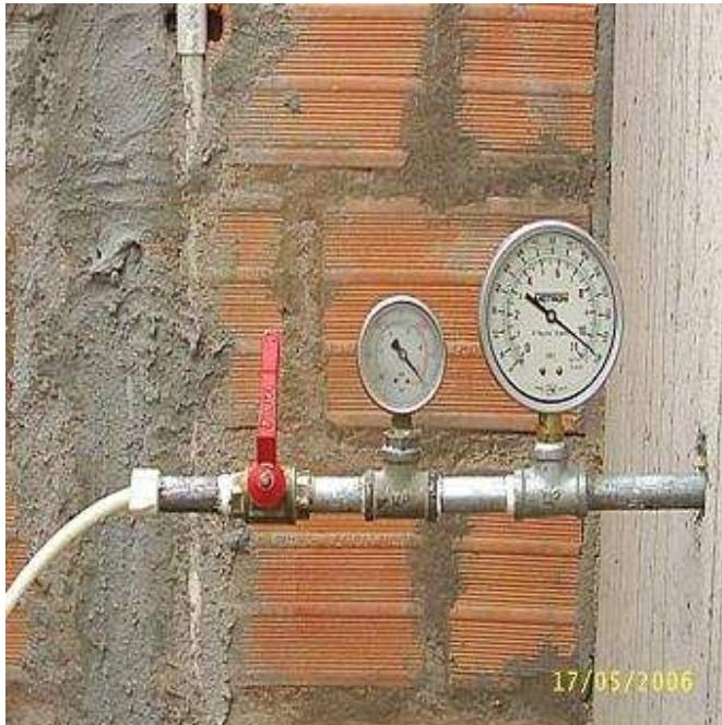
Figura 6, Calibración de manómetro
