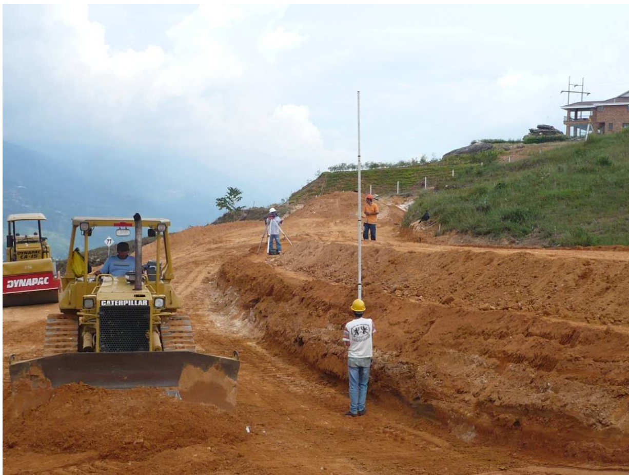
Figura 3, Movimiento de tierra
