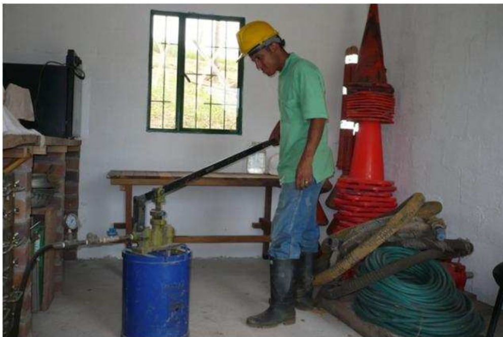
Figura 10, Ensayo de presión hidráulica
