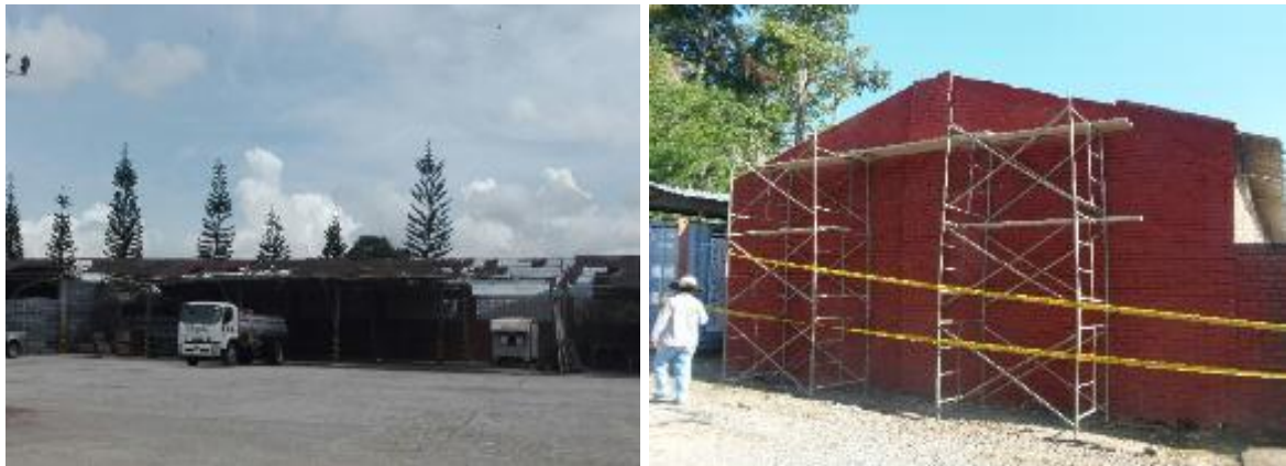
Figura 15. Estado inicial de las instalaciones.
