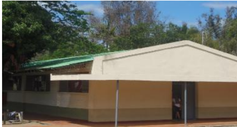
Figura 20. Estado final de la cubierta en los Alojamientos.
