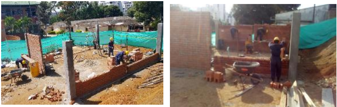
Figura 24. Trabajos de mampostería en el cerramiento del Aula.
