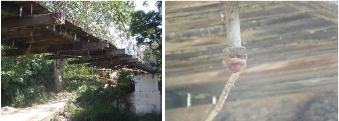
Figura 9. Visualización de la estructura metálica y sus condiciones.
