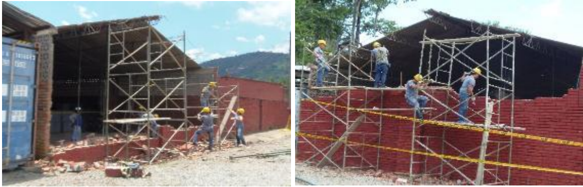
Figura 16. Estado inicial de las instalaciones.
