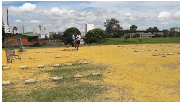
Figura 11. Ejecución de apiques para la verificación del terreno y compactación.
