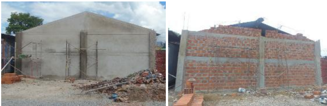
Figura 19. Trabajos de mampostería y frisado.
