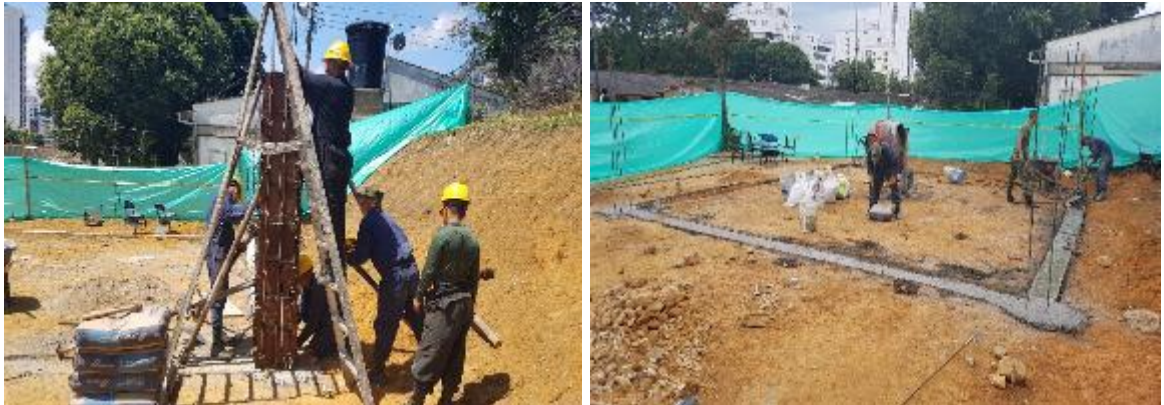
Figura 23. Fundición de vigas de amarre y columnas.
