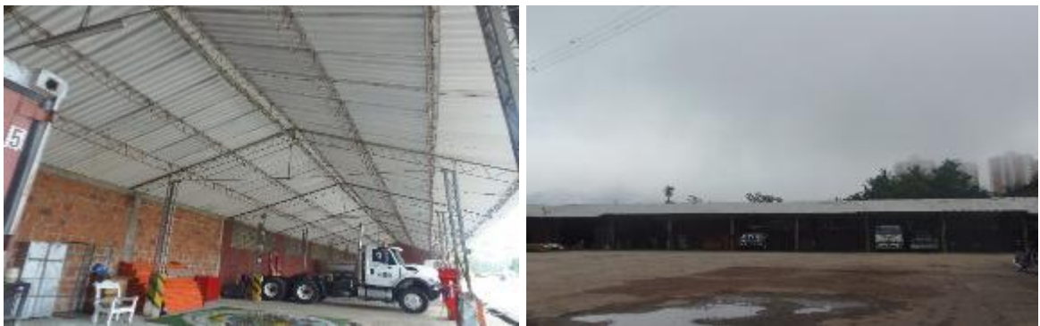
Figura 21. Estado final de la cubierta en la Sección de Transportes.
