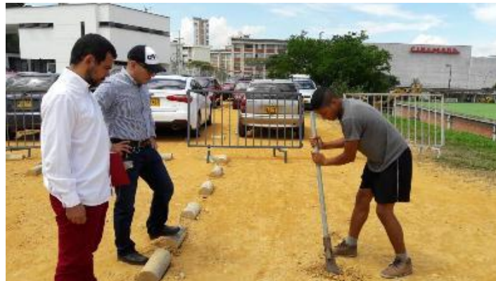
Figura 11. Ejecución de apiques para la verificación del terreno y compactación.
