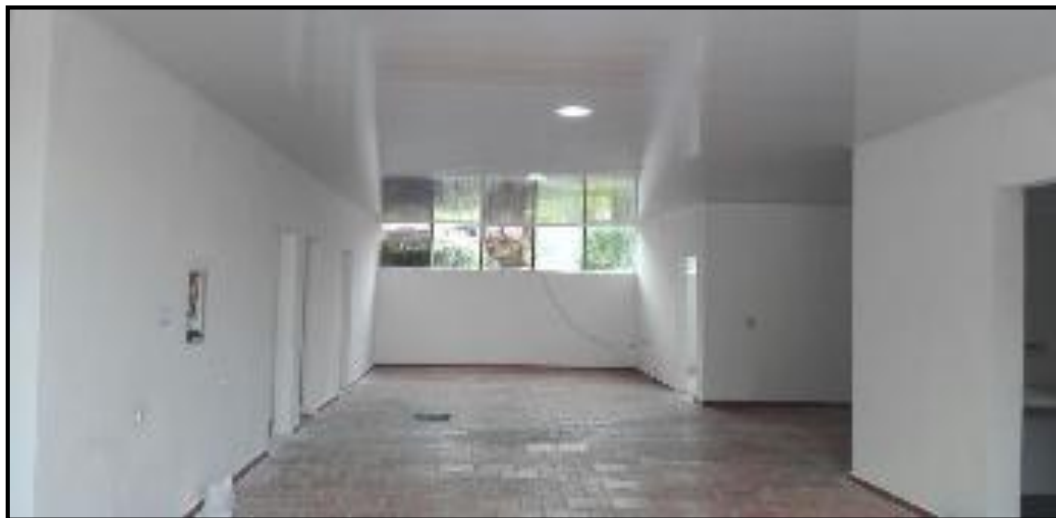
Figura 14. Entrega y culminación de obra.
