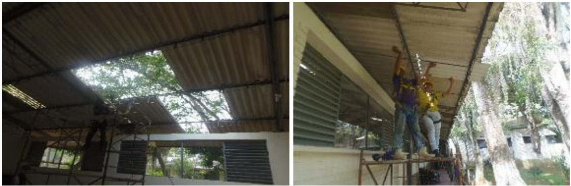
Figura 17. Trabajos en cambio de tejado de Alojamientos.
