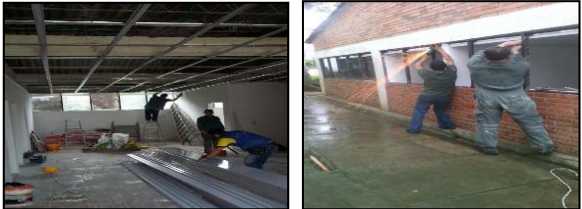
Figura 13. Trabajos de instalación de cielo raso y estructura metálica.
