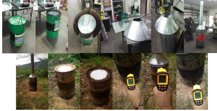
Figura 1. Construcción y ensamble de un pirolizador artesanal (Instalaciones de planta física de la Universidad Industrial de Santander-Colombia).
