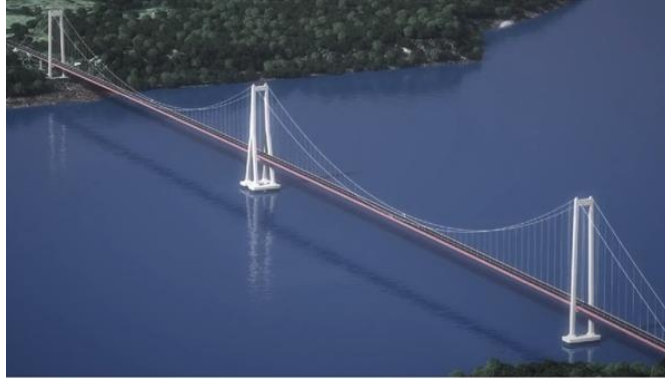
Figura 14. Puente colgante de Chacao - región de los lagos, Chile.
