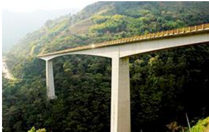
Figura 5. Viaducto el Tigre, vía Ibagué – Cajamarca, Colombia.
