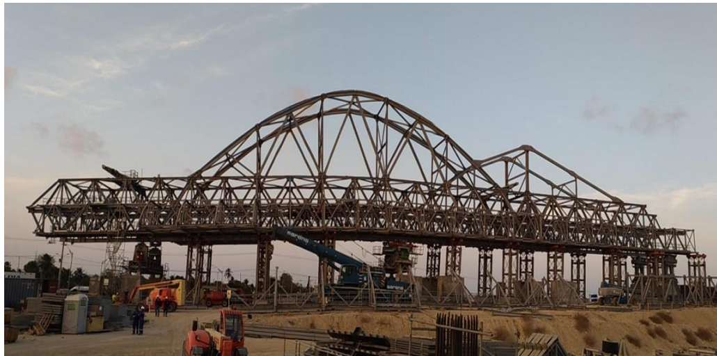
Figura 1. "M1-70-S" autocimbra superior para el puente Pumarejo.
