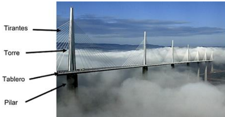
Figura 9. Partes fundamentales de un puente atirantado.
