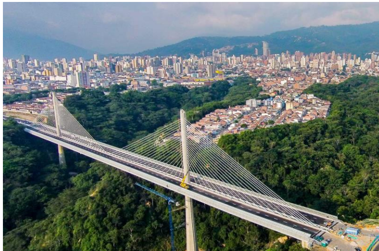
Figura 11. Viaducto carrera 9ª – Bucaramanga, Santander.
