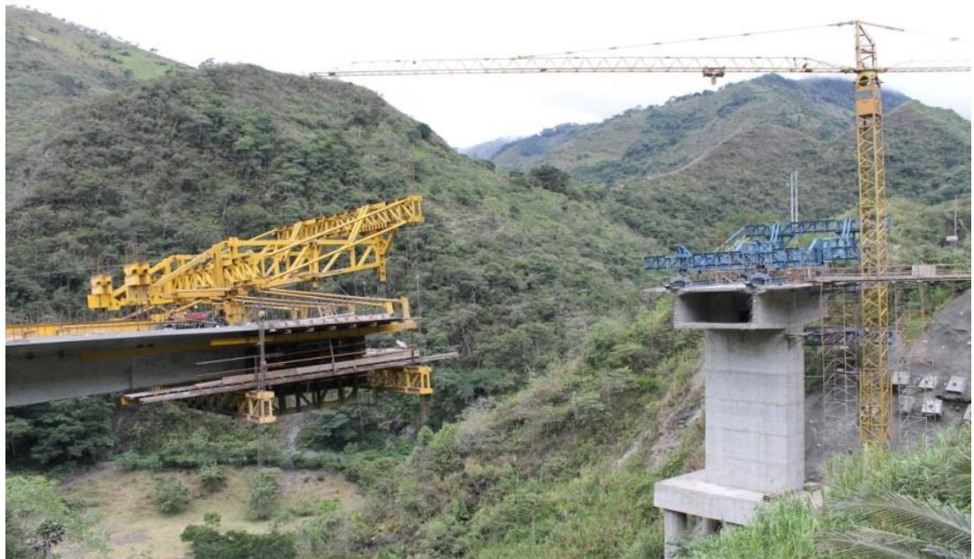
Figura 16. Puente por voladizos sucesivos fundidos “In Situ” - viaducto tramo Cisneros-Loboguerrero, vía Buga-Buenaventura, Valle.
