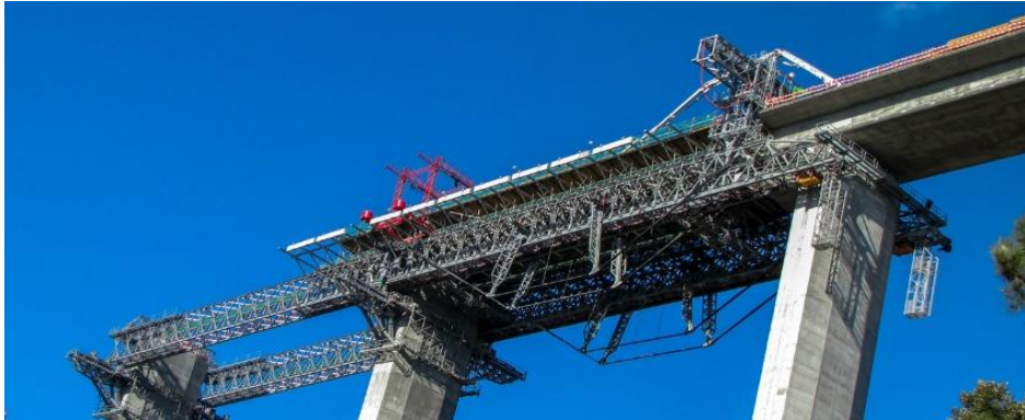
Figura 21. Cimbra autolanzable, Viaducto de Corgo - Vila Real, Portugal.
