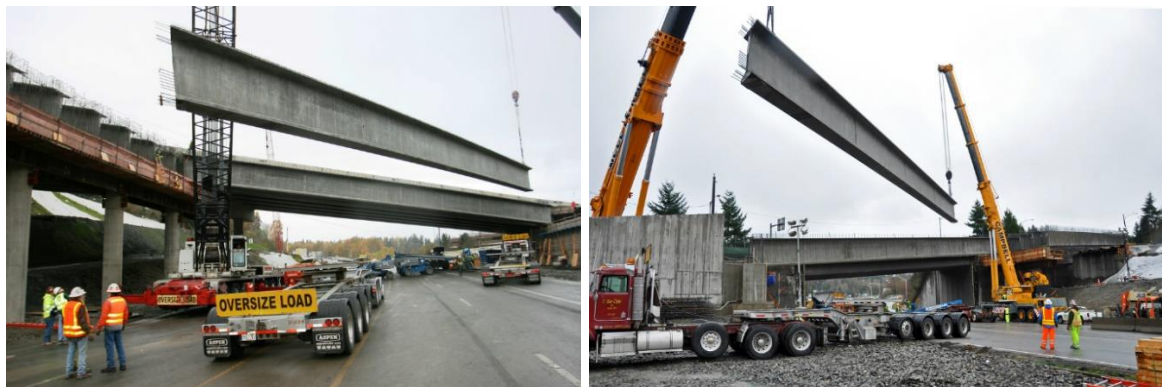
Figura 19. Izaje de vigas prefabricadas.
