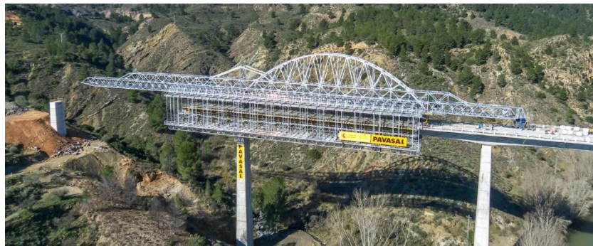
Figura 28. Puente Río Cabriel – Valencia, España.
