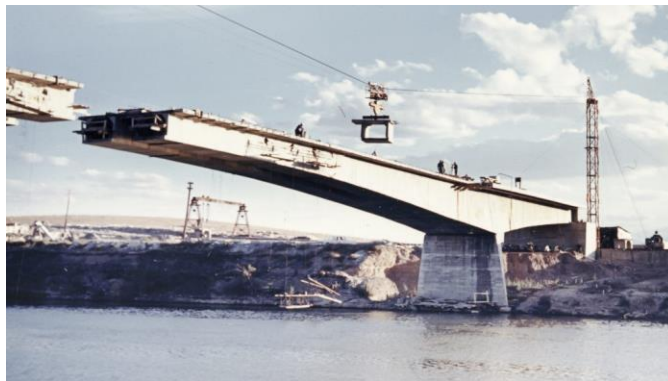
Figura 17. Encolado de dovelas prefabricadas en la construcción por voladizos sucesivos.
