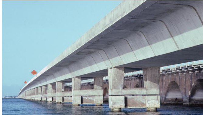
Figura 32. Puente Long Key, Layton, Florida (1982).
