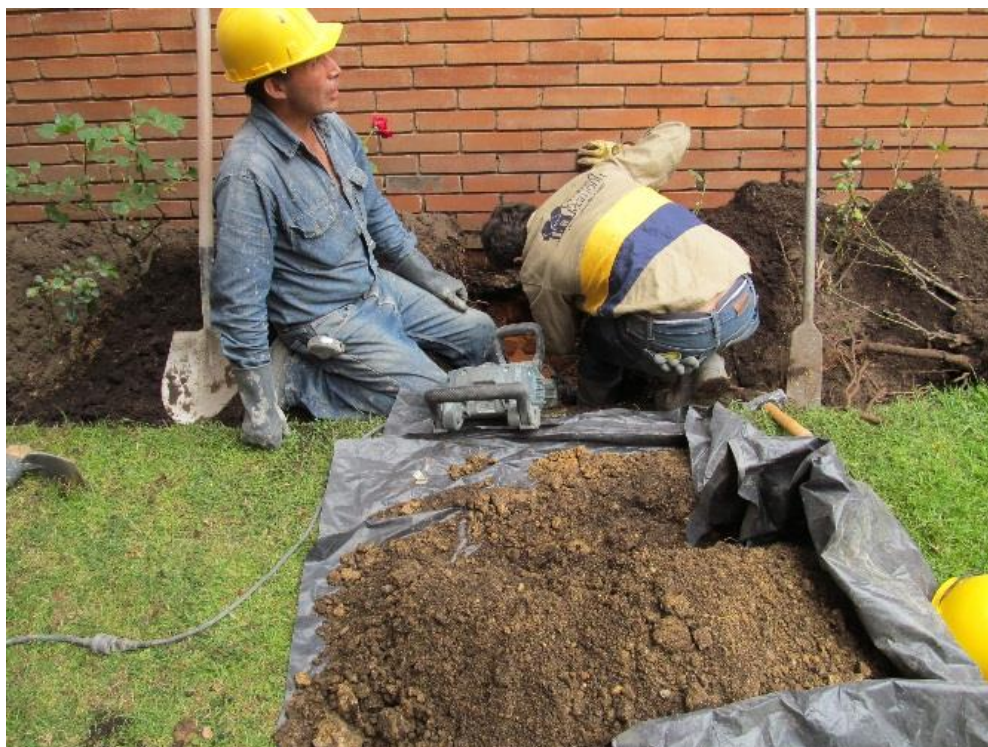
Ilustración 5. Apique para determinar características de la estructura
