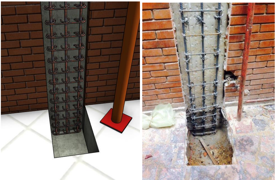
Ilustración 42. Izq. Modelado de formaleta. Der. Foto de ejecución de la actividad.
