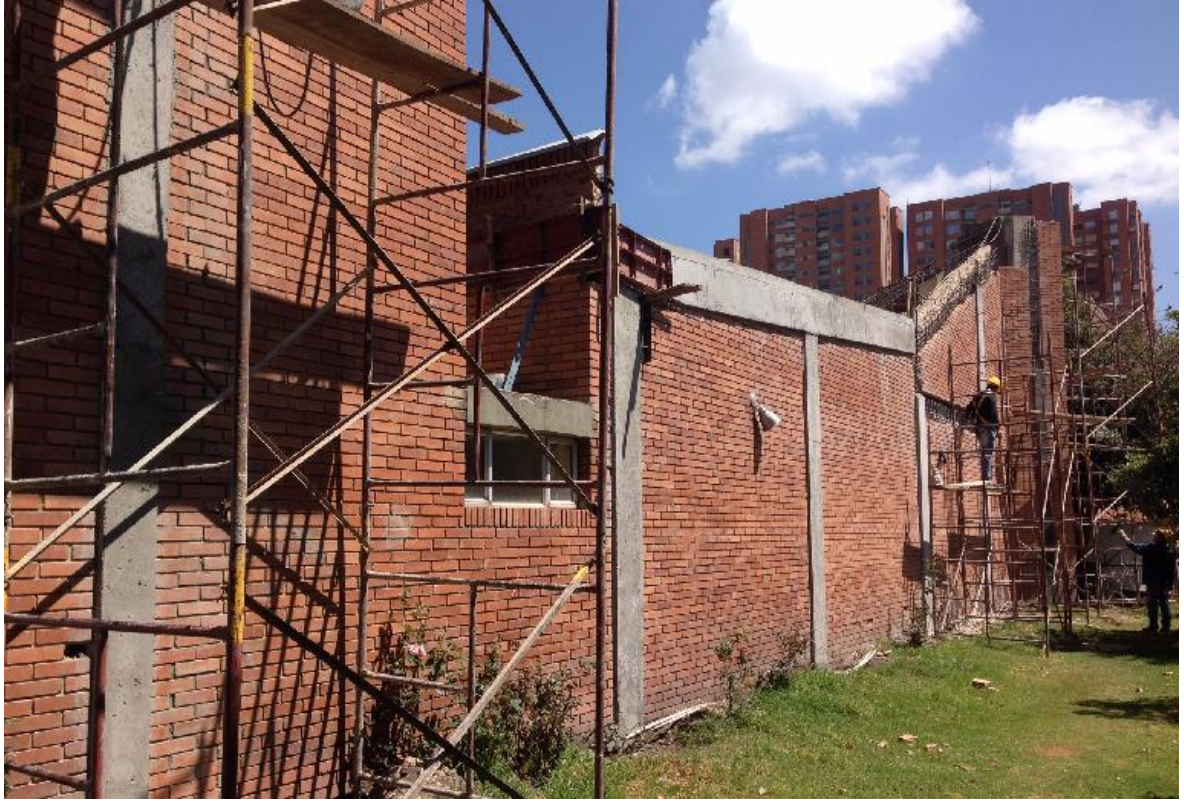
Ilustración 40. Seguimiento al proceso constructivo, primer plano posterior.
