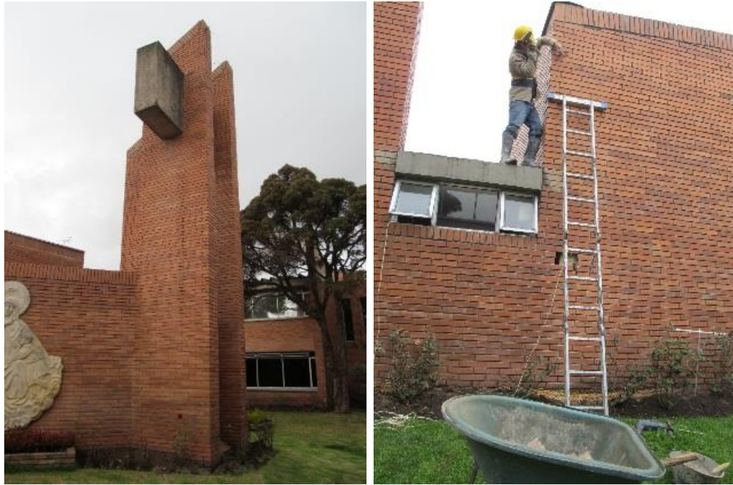
Ilustración 8. Registro fotográfico del levantamiento
