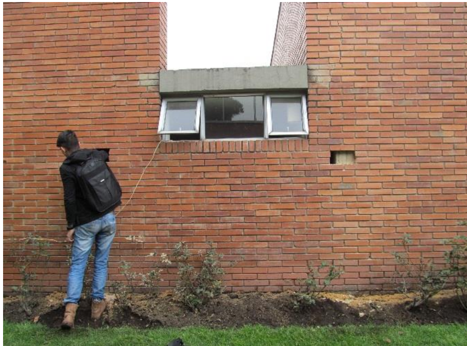
Ilustración 6. Toma de medidas para determinar características de la estructura
