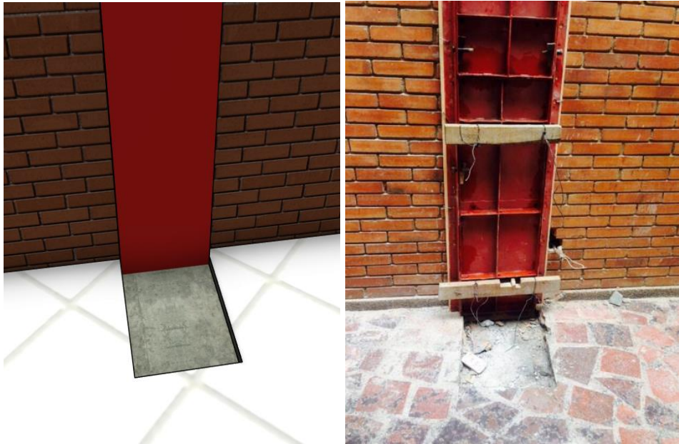
Ilustración 42. Izq. Modelado de formaleta. Der. Foto de ejecución de la actividad.
