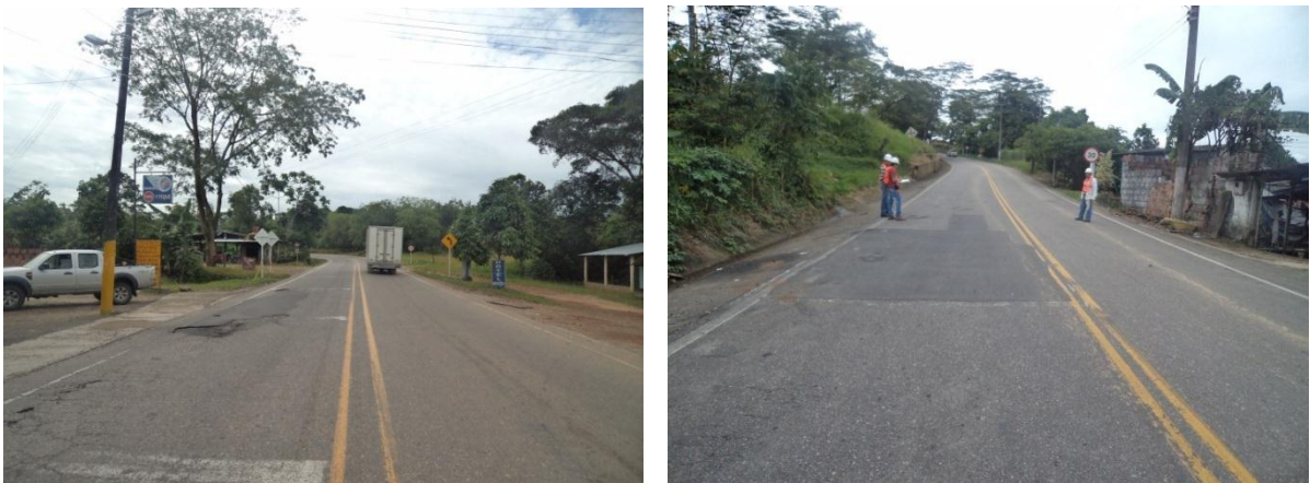
FIGURA 2. Fotografías del inicio de cada tramo; PR0 para Monterrey-Aguazul (izq), PR78 para El Secreto-Aguaclara (der).
