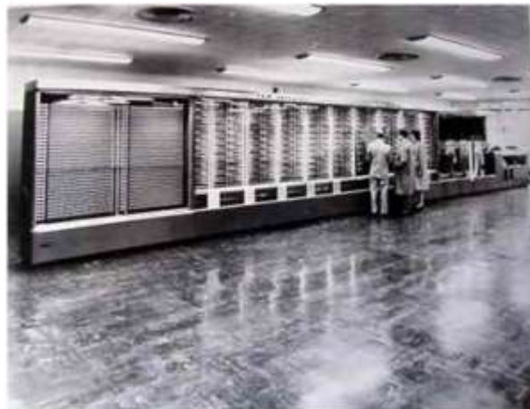
Figura 22. Aspecto del Mark I
