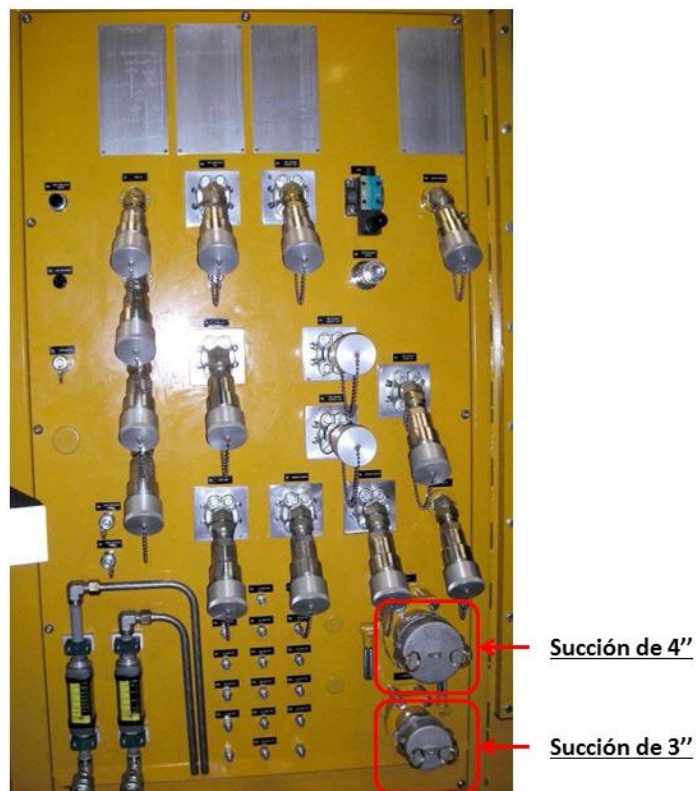
Figura 25. Acoples de succión de 3" y 4" desde tanque principal.
