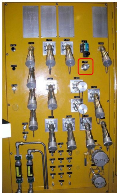
Figura 18. Puerto de suministro de supercarga S6.
