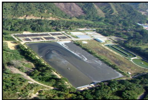
Figura 9.1. Planta de tratamiento de Aguas Residuales de Río Frio
