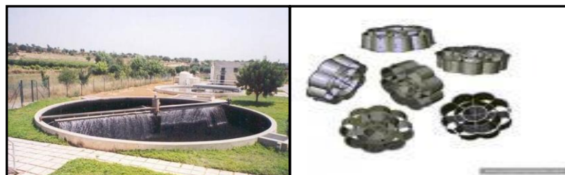
Figura 5.2. Filtro Percolador y Medio Filtrante
