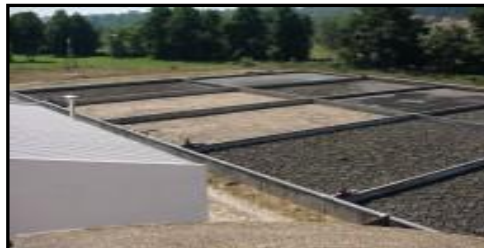
Figura 5.4. Lechos de Secado de Lodos
