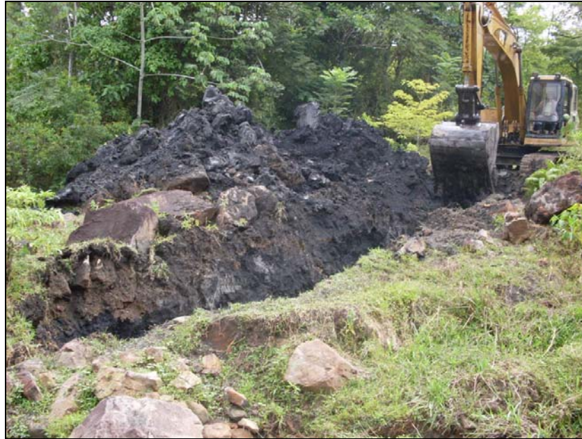
Figura 4. Trabajo de Trincheras con retroexcavadora.
