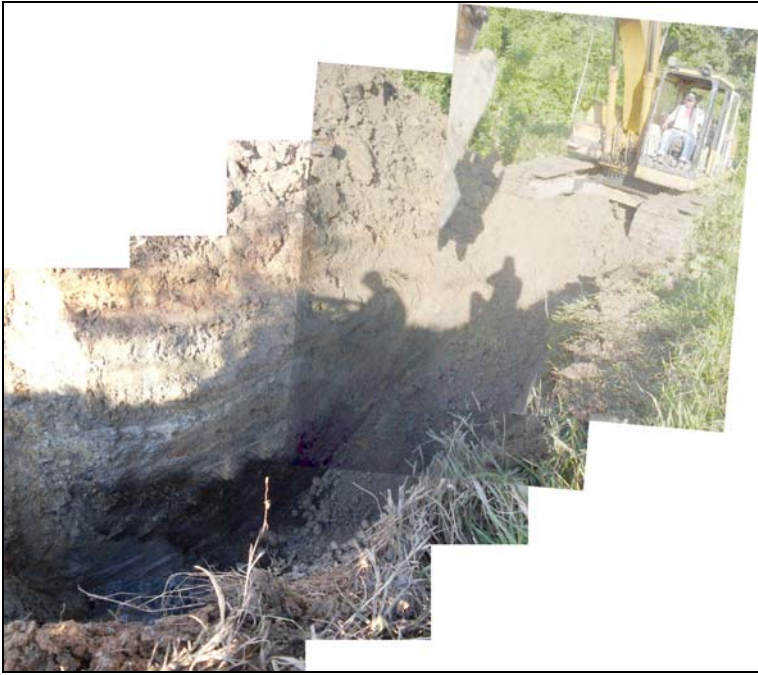
Figura 11. Mosaico fotográfico de la trinchera por medio de retroexcavadora, que se debió realizar para poder localizar un manto de carbón de 1,05 m de espesor, el cual fue denominado manto N° 3, ubicado en la Finca La Gaitana.
