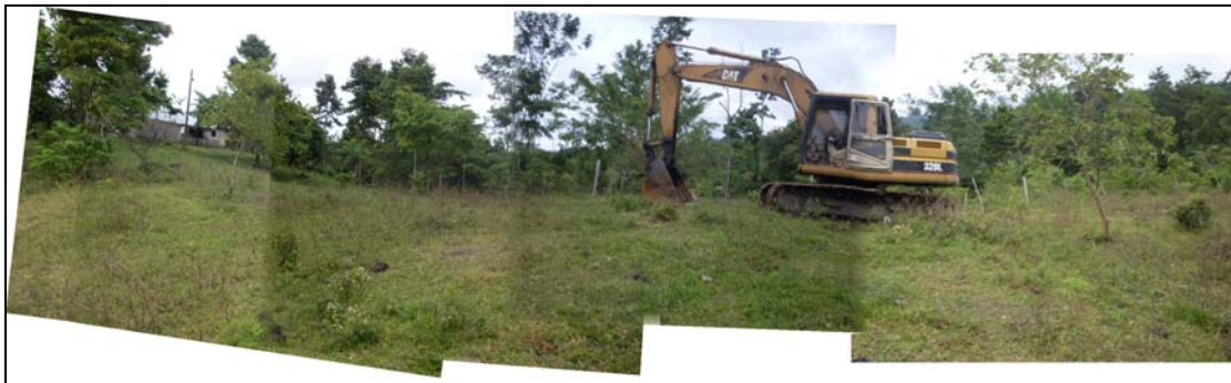
Figura 8. Mosaico fotográfico de la llegada de la retroexcavadora CAT 320L, a la finca La Gaitana propiedad del señor Reynaldo Espinoza
