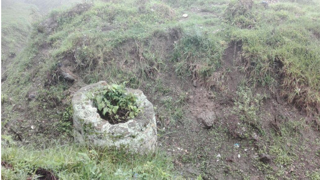
Figura 53. Punto de agua 4
