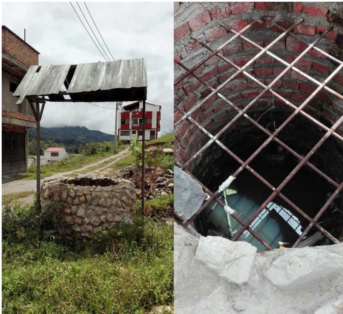
Figura 51. Punto de agua 2
