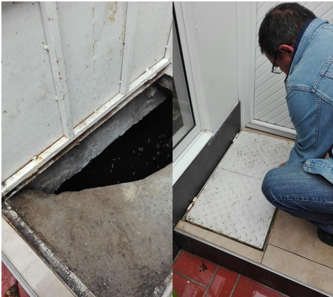
Figura 50. punto de agua 1
