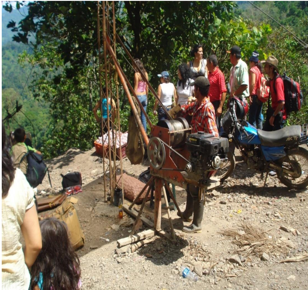
Figura 24. Sistema de guaya montado en el kilómetro 14 vía Cimitarra-Landázuri
