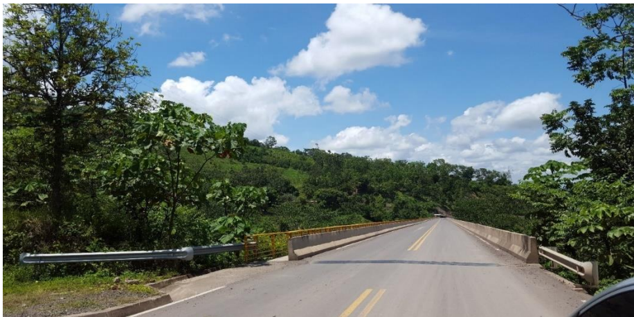
Figura 21. Viaducto kilómetro 17 vía Cimitarra - Landázuri
