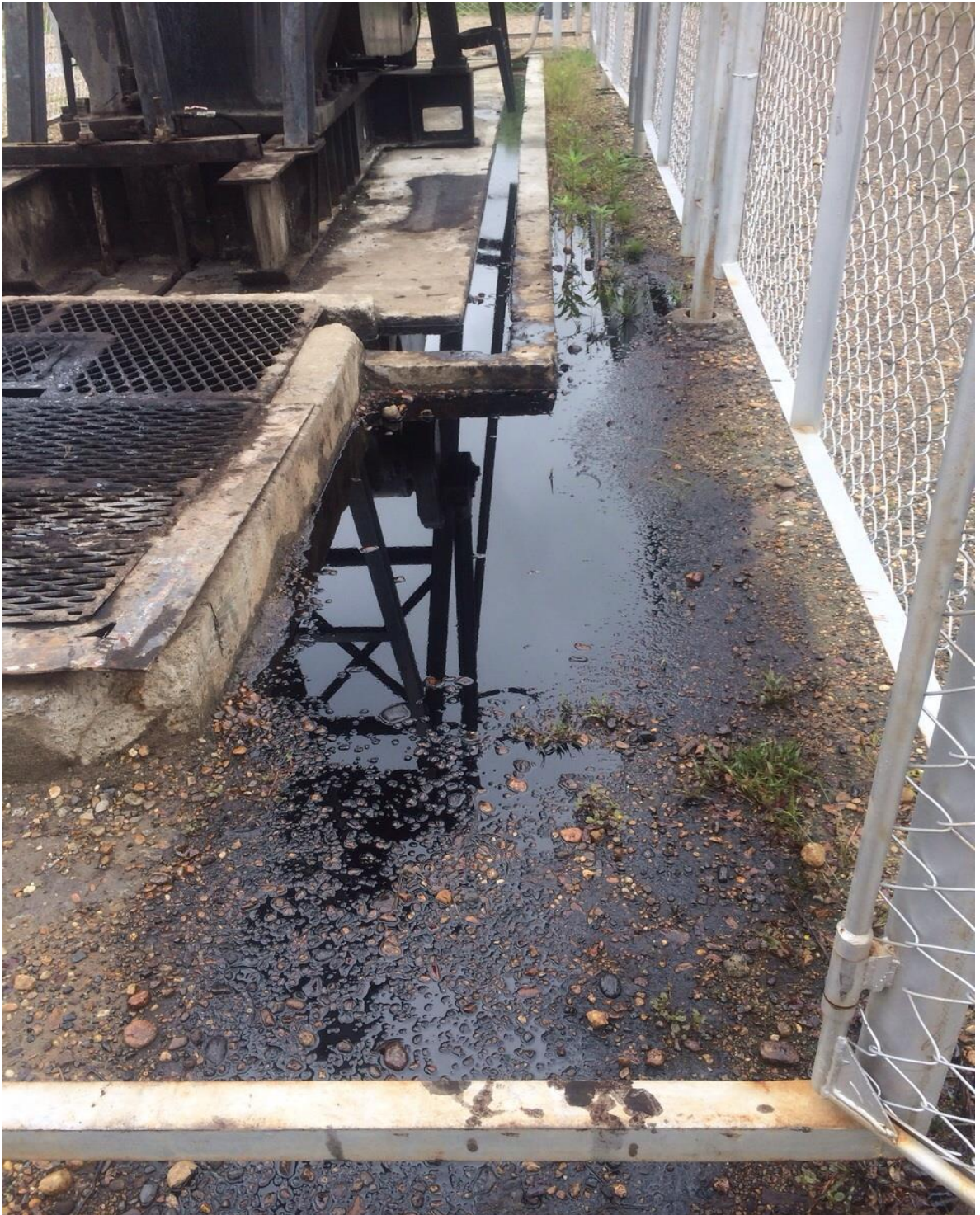
Figura 46. Instalaciones de un Pozo en Campo Palagua
