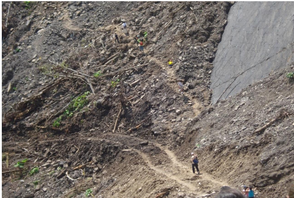
Figura 23. Movimiento de tierra del kilómetro 14 vía Cimitarra- Landázuri
