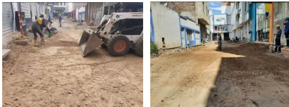
Figura 22. Extensión de la subbase granular con mini-cargador
