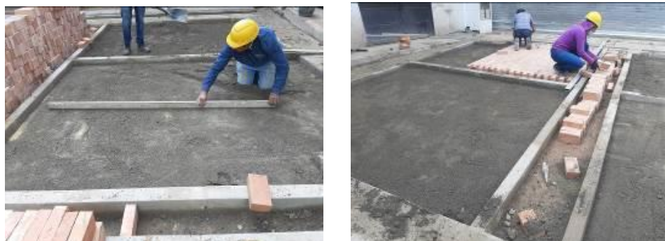
Figura 26. Instalación de agregado fino y adoquín
