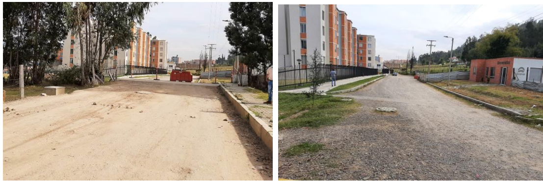
Figura 29. Tramo de vía a intervenir
