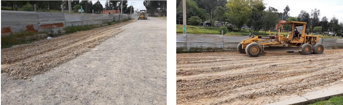
Figura 30. Conformación de la subrasante
