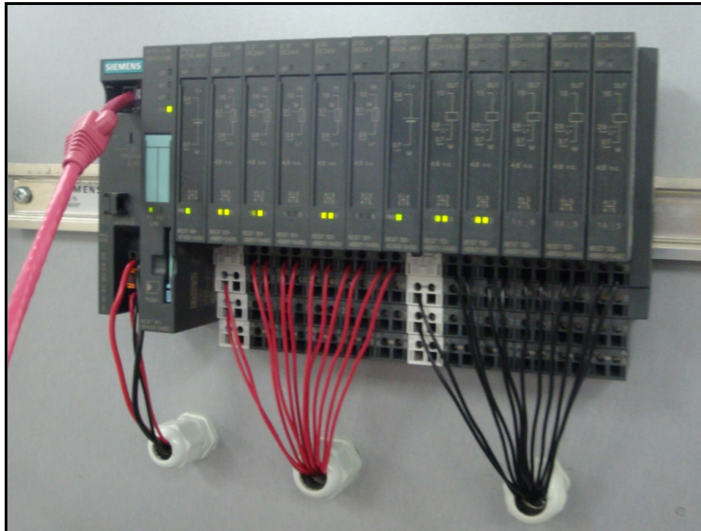
Figura 43. Módulo de periferia descentralizada ET200S.
