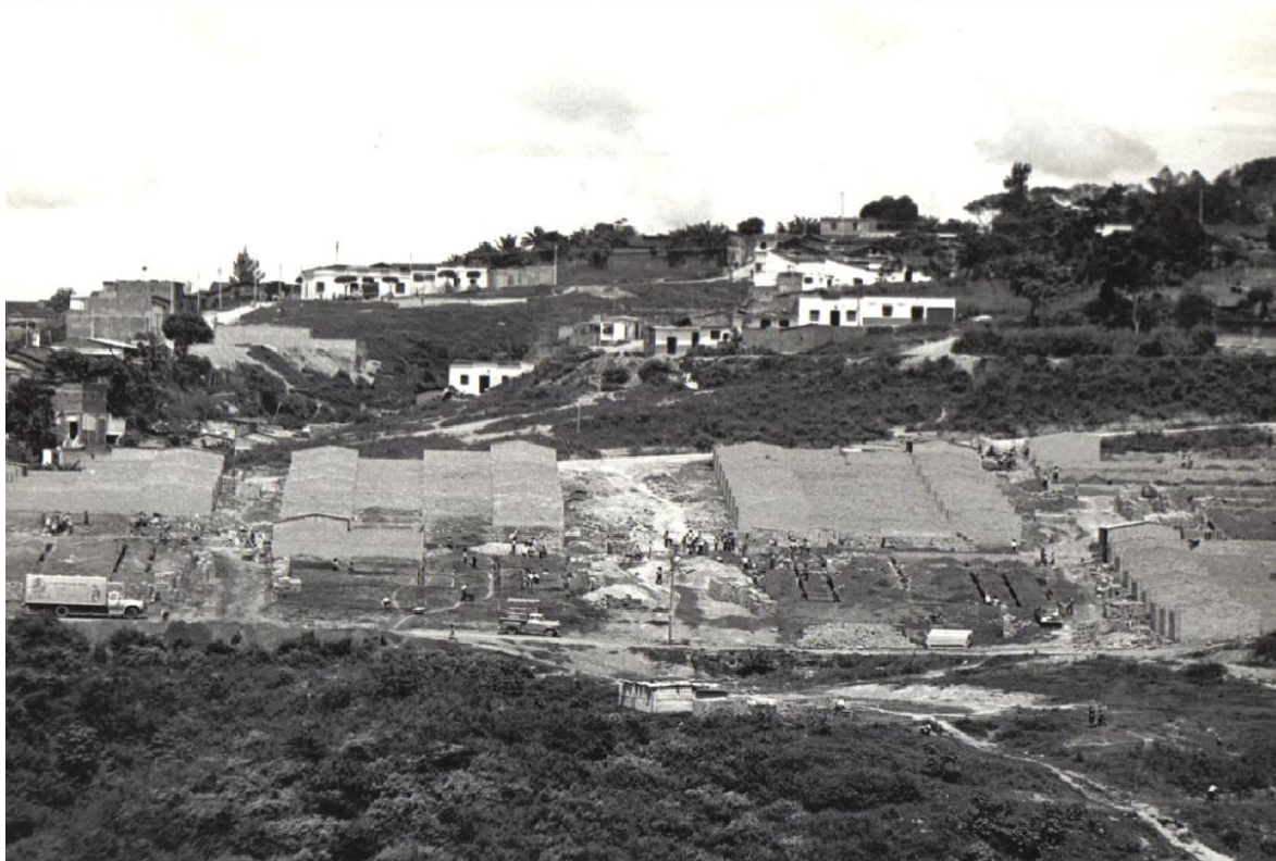
Dos panorámicas del proceso de construcción de Zapamanga. Fuente. ICT. En: Néstor Rueda Gómez, 405.
