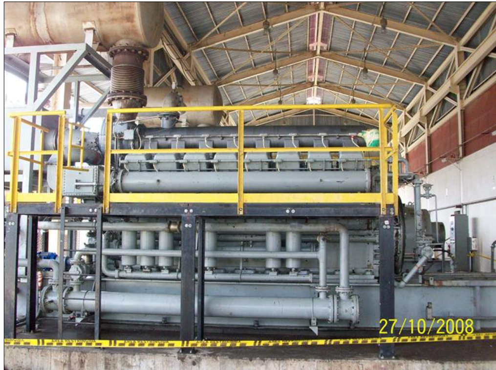
Figura 3. Motogeneradores existentes
