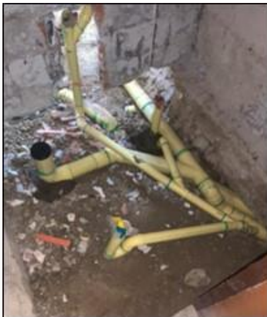
Figura 4. Registro fotográfico de instalación sanitaria.
