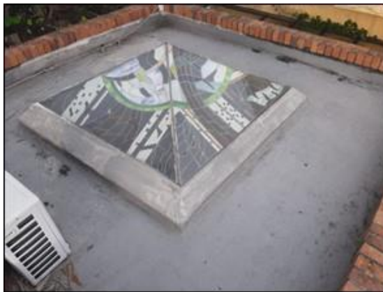
Figura 18. Fotografía cubierta a intervenir.
