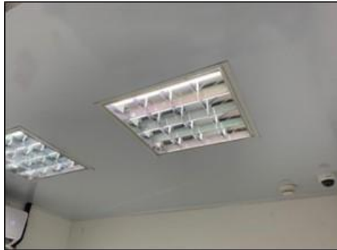
Figura 22. Fotografía nuevo cielo raso en PVC.
