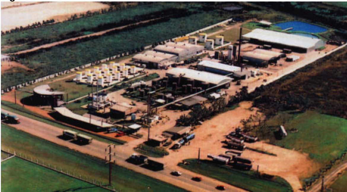
Figura 15 Planta de tratamiento de IDM
