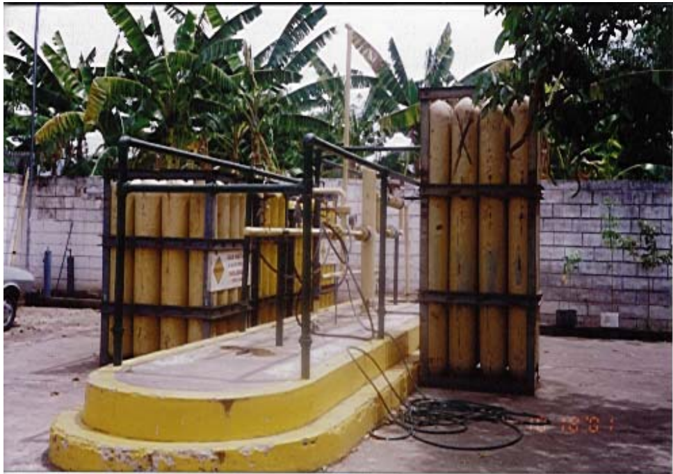
GRAFICO H3. Estación de descompresión el Juncal
