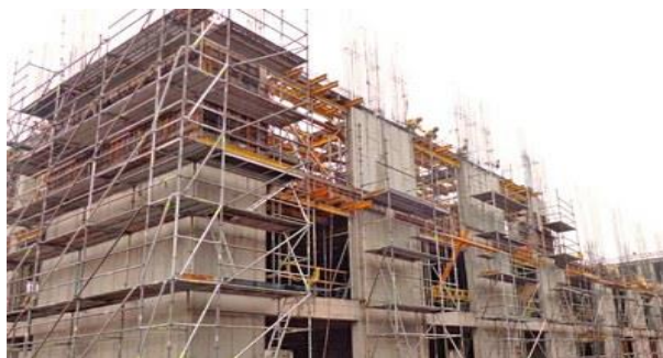
Figura 1. Estructura Temporal tipo Andamio.
