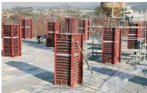
Figura 2. Estructura Temporal tipo Encofrado.
