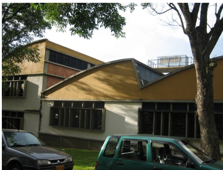
Foto 1 – Edificio del Laboratorio de hidráulica UIS.
