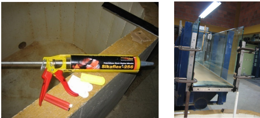
Fig. 3 – Instalación de perfiles de acero inoxidable.
