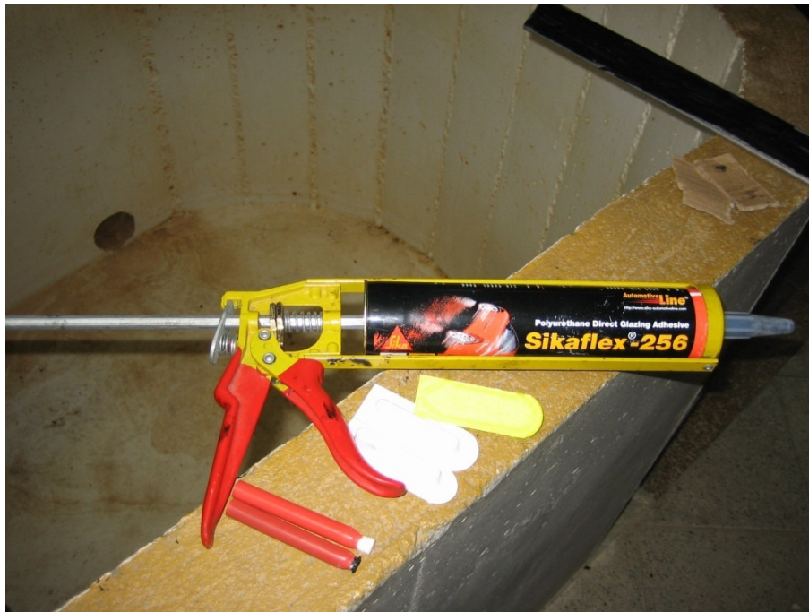
Foto 4 – Instalación de perfiles. Productos utilizados para la instalación (Limpiador, imprimante y adhesivo).
