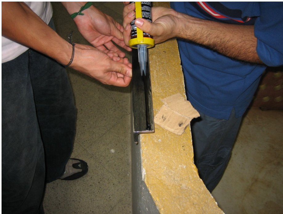
Foto 2 – Instalación de perfiles. Aplicación del Adhesivo Sikaflex®256.
