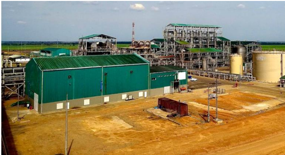
Figura 10. Área de cogeneración
