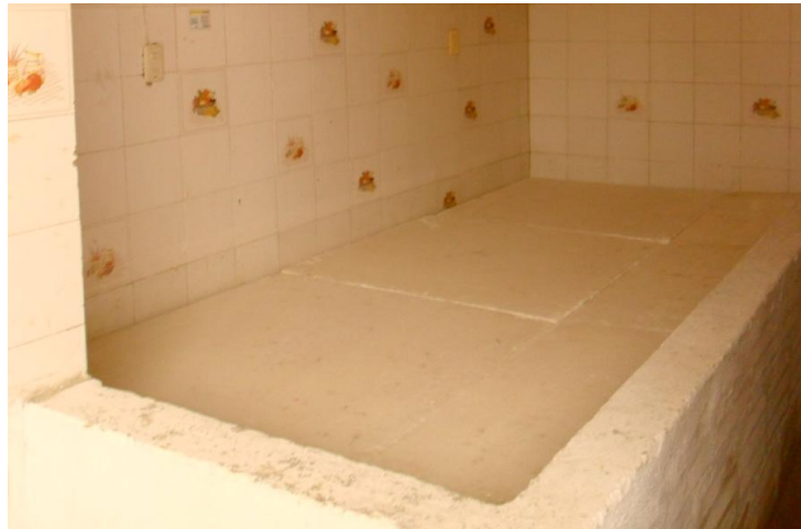
Fotografía 5 Tanque de curado para cilindros y vigas de concreto
