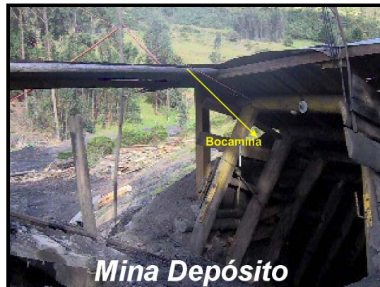
Figura 1.7 Fotografía boca de mina, mina Depósito
