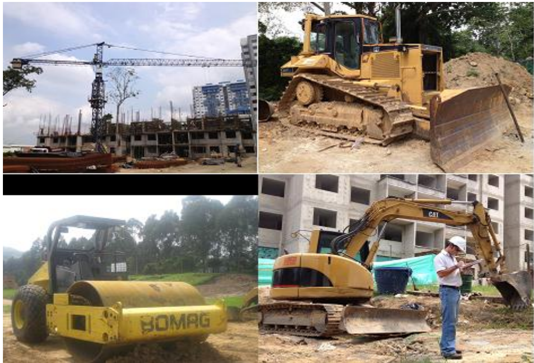
Figura 7. Maquinara para movimiento de tierra
