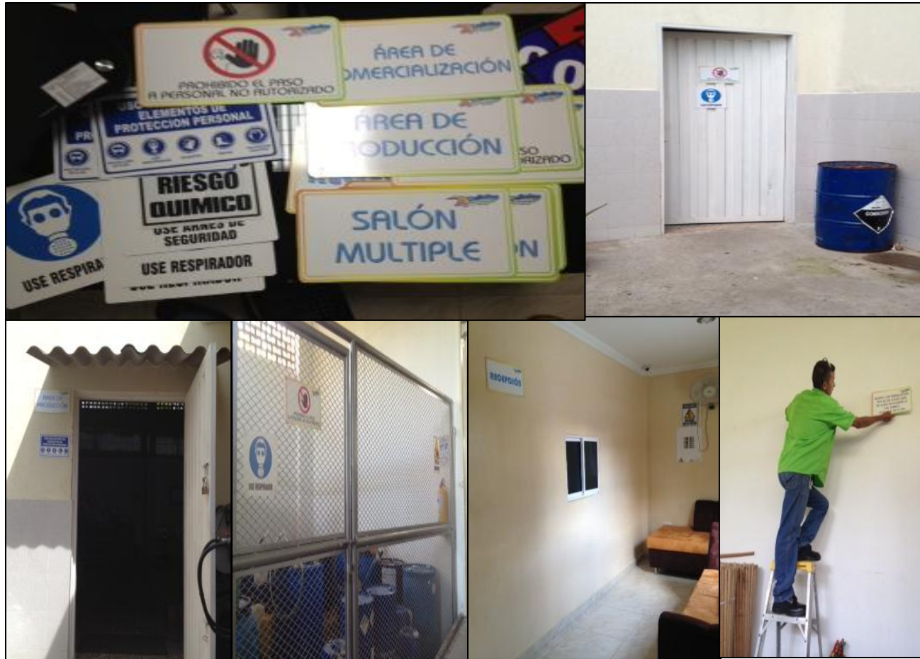
Imagen 6: Señalización (Informativa, Epp, Rombo NFPA 704) , contra incendios, reposición EPP
