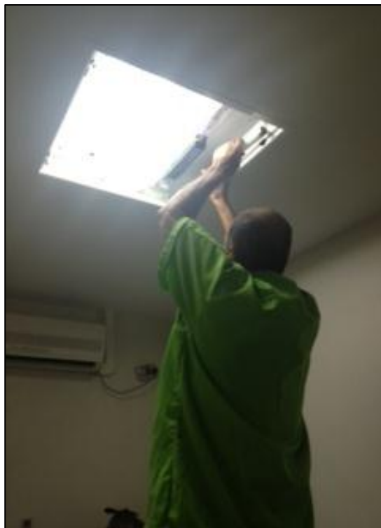
Imagen 4. Mantenimiento a las fuentes iluminación
