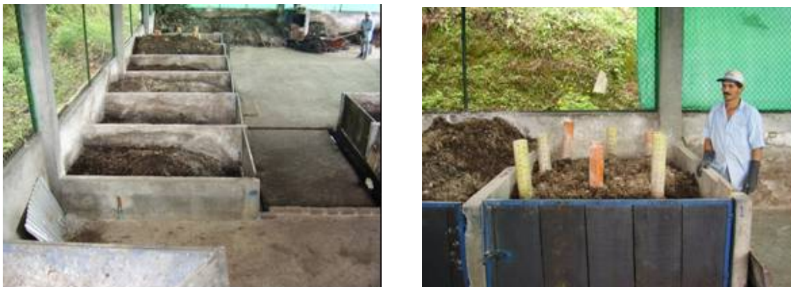
Figura 50. Celdas para Secado, tubos de aireación de las Celda de secado
