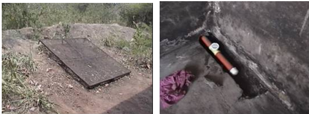
Figura 86. Rejilla y sistema de recolección lixiviados de las celdas
