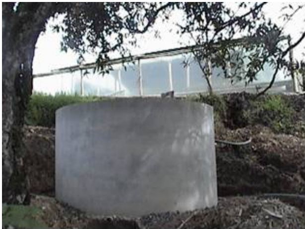
Figura 15. Tanque de almacenamiento de lixiviados
