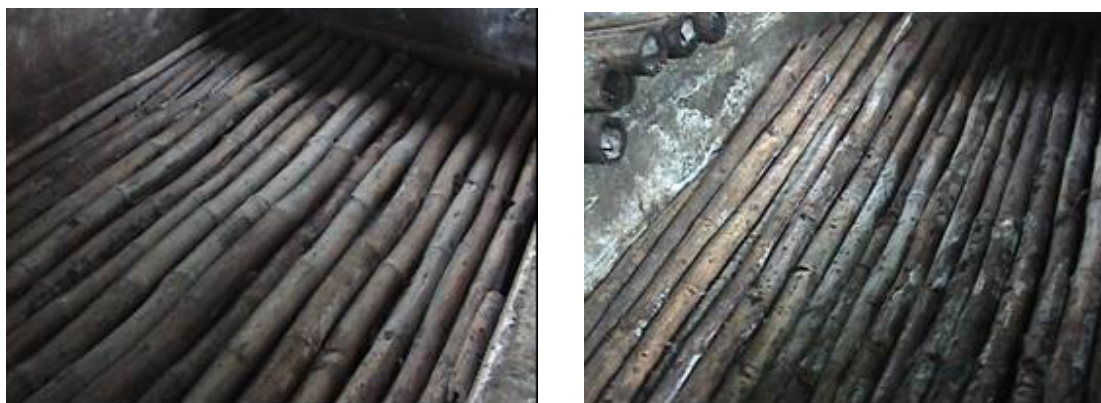
Figura 51. Guadua como falso fondo para percolar el lixiviado
