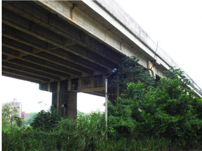
Figura 3.1 Foto en perspectiva del viaducto la Flora.
