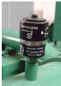
Figura 15. Indicador de restricción de aire
