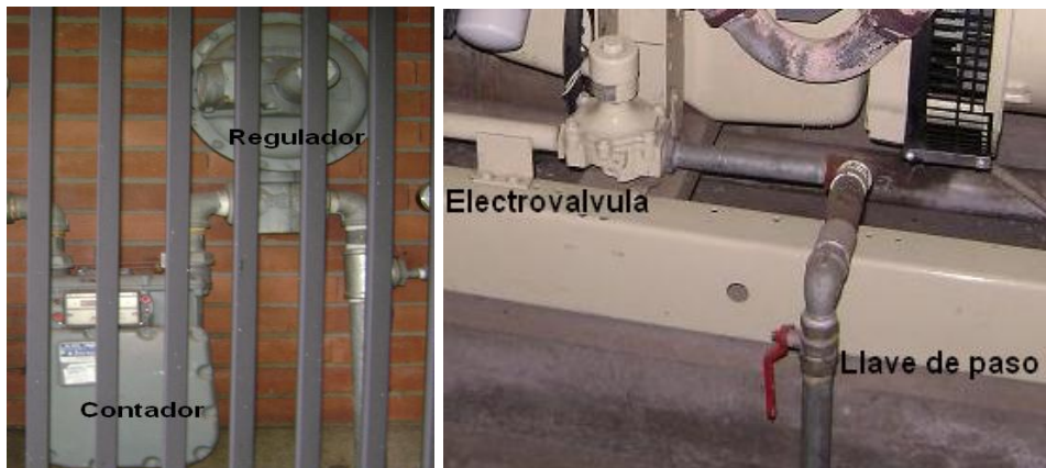
Figura 44. Sistema de combustible
