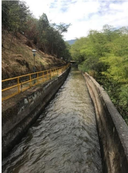
Figura 1. Canal de aducción de la hidroeléctrica La Cascada
