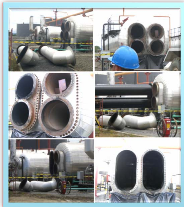
Figura 32. Fotografía Mantenimiento Tubos de Fuego
