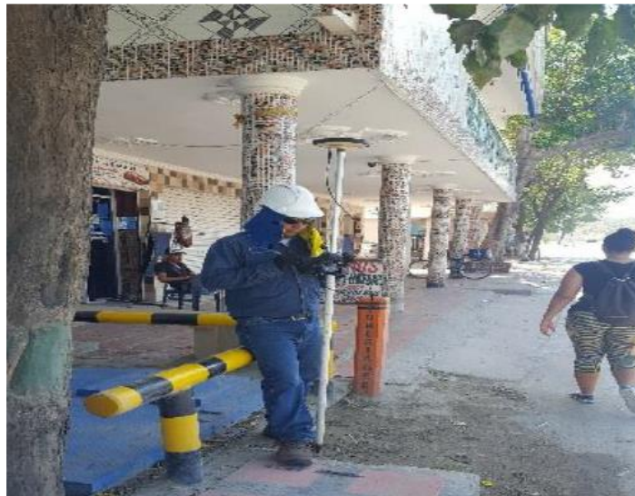
Foto 10 TAP y Válvula Ferrocarril GPS de indicación de falla localizada
