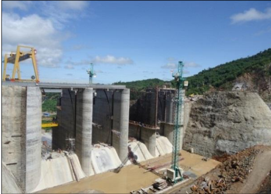
Figura 13. Avance de la estructura de control del mes de Julio
