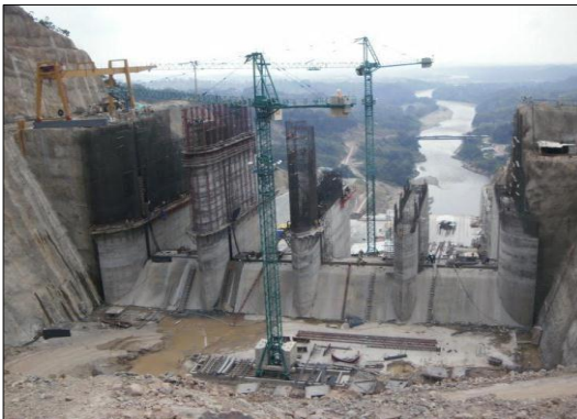
Figura 14. Avance de la estructura de control del mes de Octubre.
