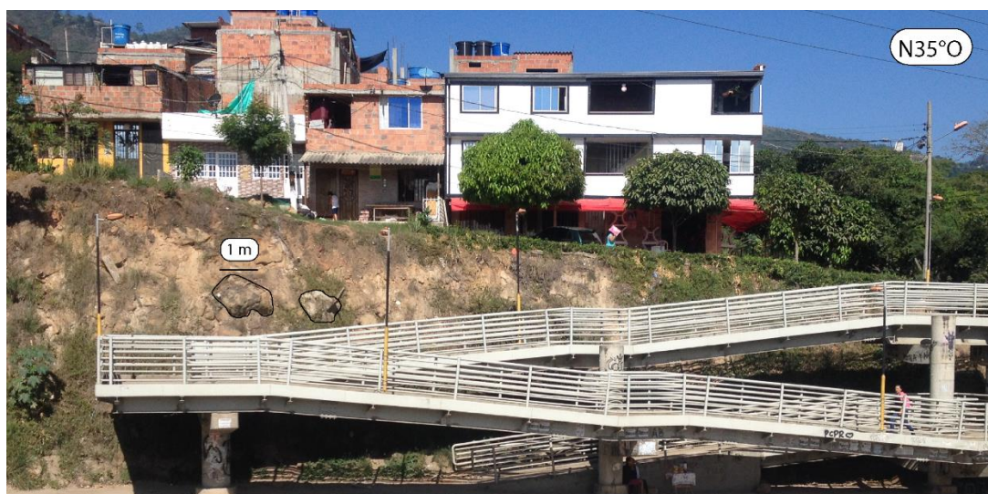
Figura 22. UGS Sfe1. Afloramiento de la unidad en el Talud principal en la entrada del barrio Mirador de San Juan.
