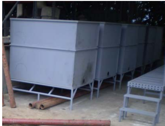
Figura 52. Drenaje y aspecto final de los tanques construidos
