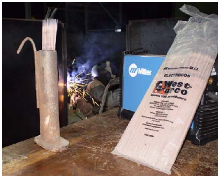
Figura 11. Soldadura por arco eléctrico con electrodo revestido
