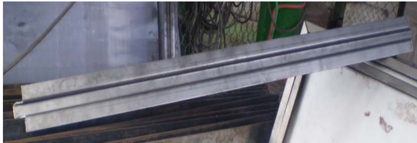
Figura 47. Aspecto final de la construcción de los atiesadores
