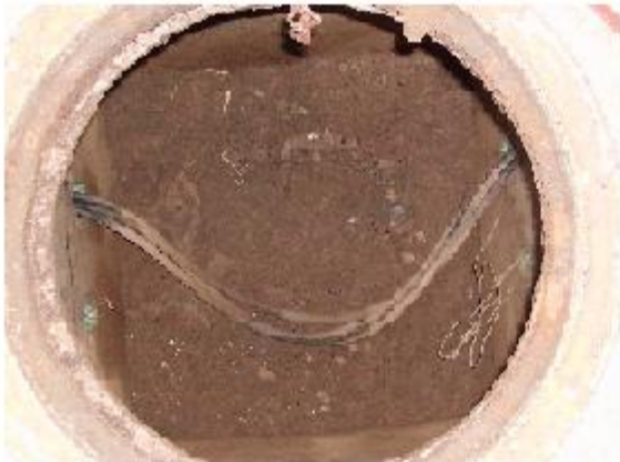
Caja de Inspección CIP1
