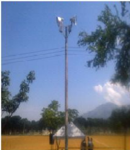
Poste de concreto de 8 m PC26, Retención
