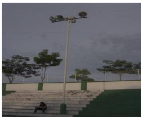
Poste metálico PT4
