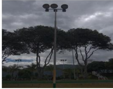
Poste metálico PB1
