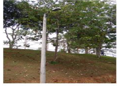
Poste de concreto 8 m PC15, Retención
