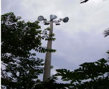
Poste de concreto 8 m PC22, Retención
