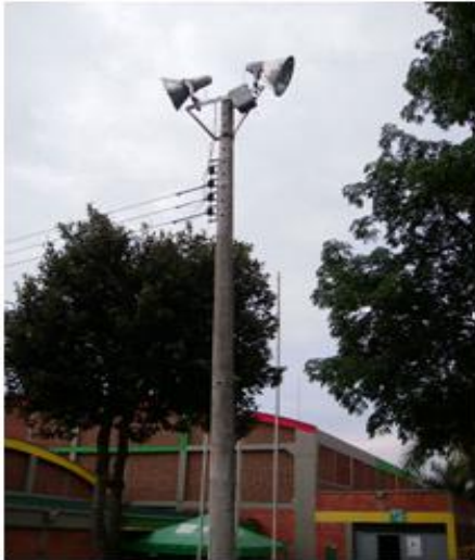
Poste de concreto de 8 m PC26, Retención
