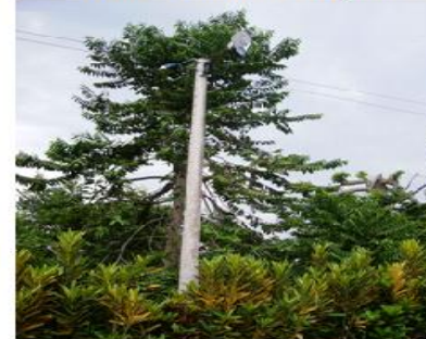
Poste de concreto 8 m PC21, Paso
