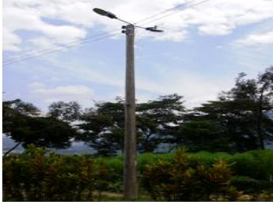
Poste de concreto 8 m PC17, Retención
