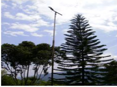
Poste de concreto 8 m PC13, Retención con templete
