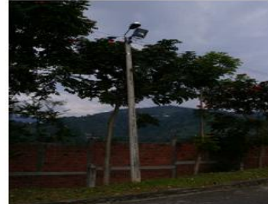
Poste de concreto 8 m PC21, Paso
