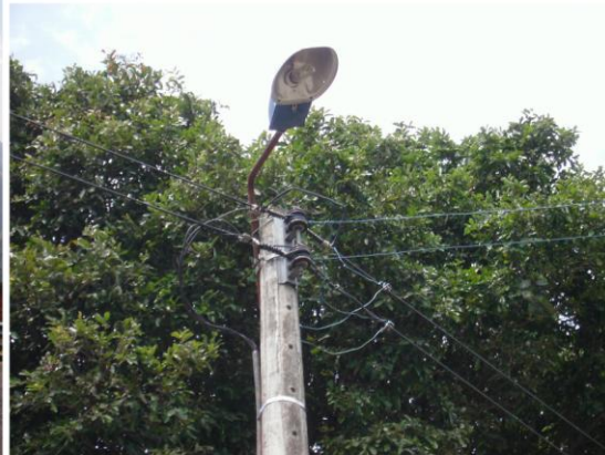
Poste de concreto 8 m PC9, Retención
