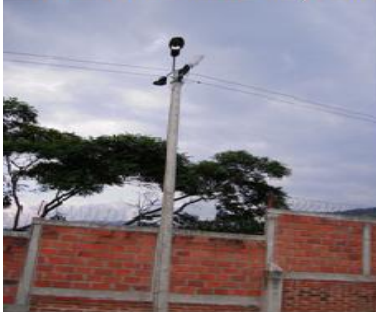
Poste de concreto 8 m PC19, Paso
