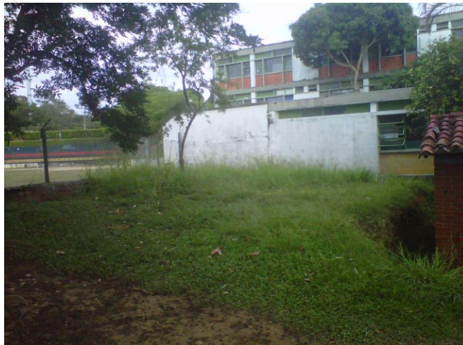
Fig. 96 Ubicación del Nuevo Transformador y su Respectivo Sistema de Puesta a Tierra. Fuente: Autores.
