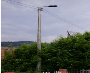
Poste de concreto 8 m PC22, Retención
