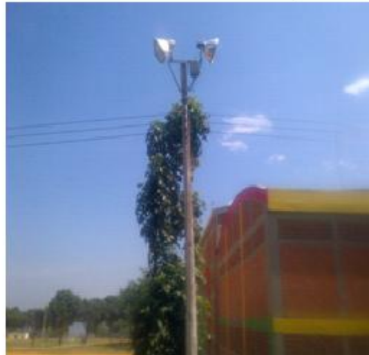
Poste de metálico de 8 m PS1, Retención con templete
