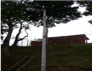
Poste de concreto 8 m PC20, Paso
