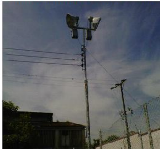
Poste de metálico de 8 m PS1, Retención con templete
