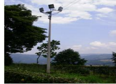
Poste de concreto 8 m PC18, Paso
