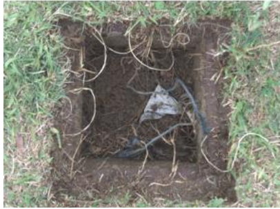
Caja de Inspección CI_B4
