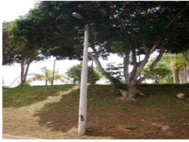
Poste de concreto 8 m PC14, Retención
