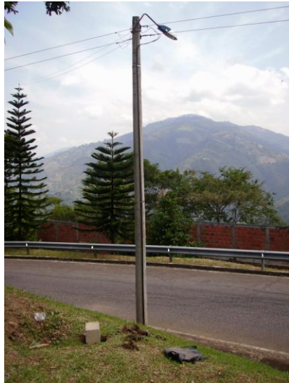
Poste de concreto 8 m PC9, Retención
