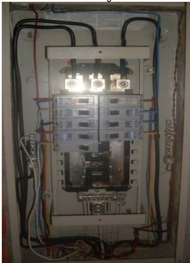
Figura 25. Tablero de uso final TCD
