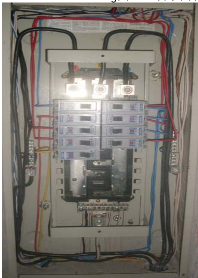
Figura 24. Tablero de uso final TCC
