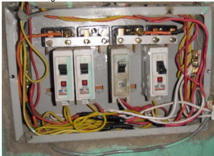
Figura 26. Tablero de uso final TCF
