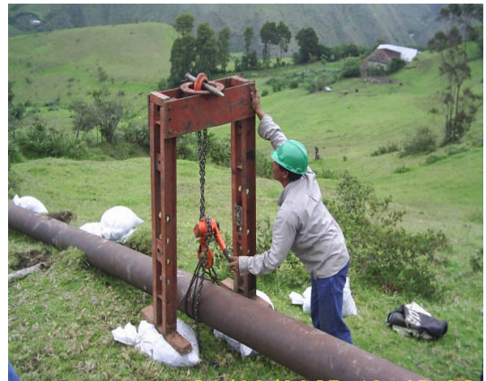
Fig. 2 Montaje de tuberías para gasoducto.
