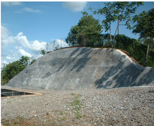
Fig. 1 Estabilización de Taludes.
