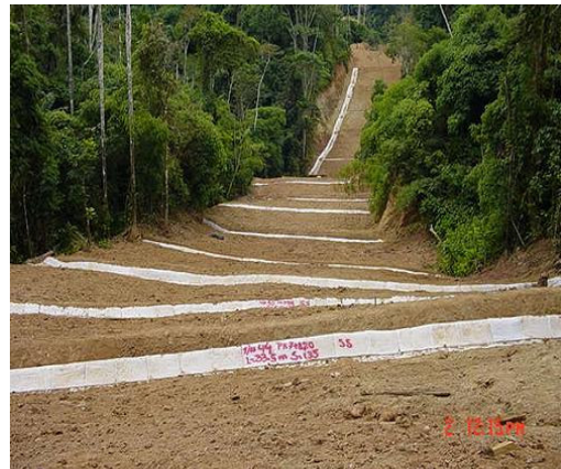
Fig. 6 Construcción de cortacorrientes.
