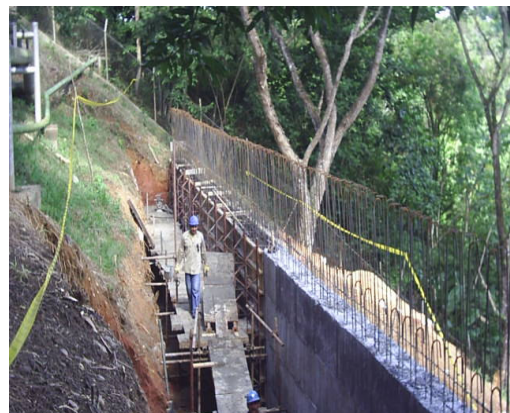
Fig. 10 Construcción de Muro de contención concreto forzado.
