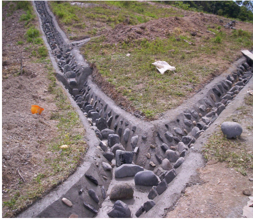
Fig. 3 Construcción de canales recolectores.
