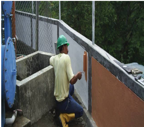
Fig. 9 Adecuaciones de Casinos y Bodegas
