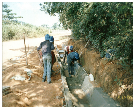
Fig. 8 Construcción de Cuneta.
