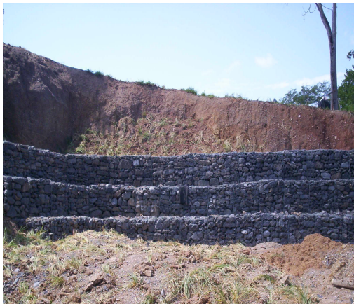
Fig. 5 Construcción de Gaviones.
