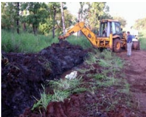
Fig. 7 Movimientos de tierra Construcción filtros.
