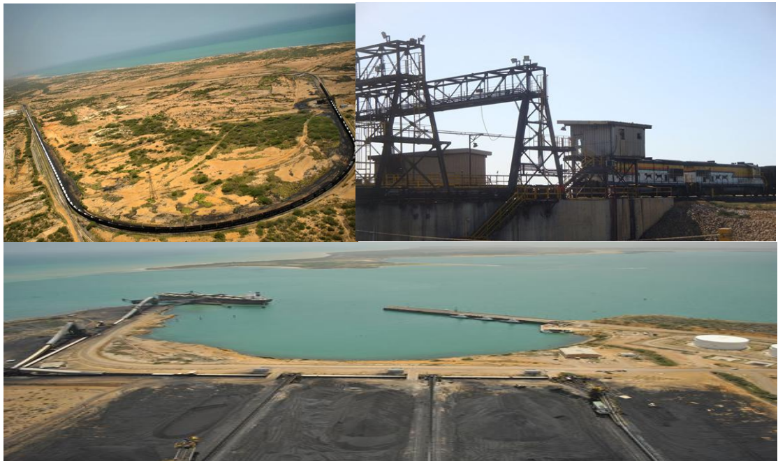
Figura 17. Zona de descargue en Puerto Bolívar
