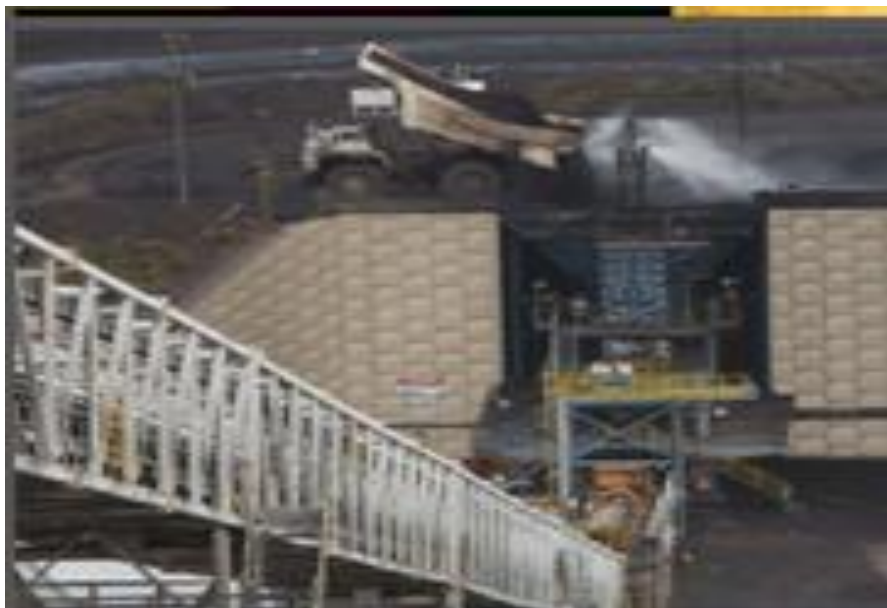
Figura 14. Descargue en planta trituradora de carbón
