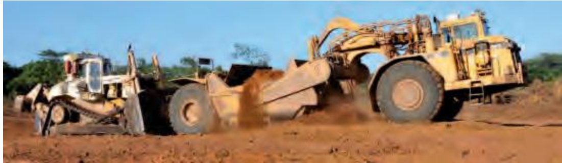
Figura 7. Remoción de suelo
