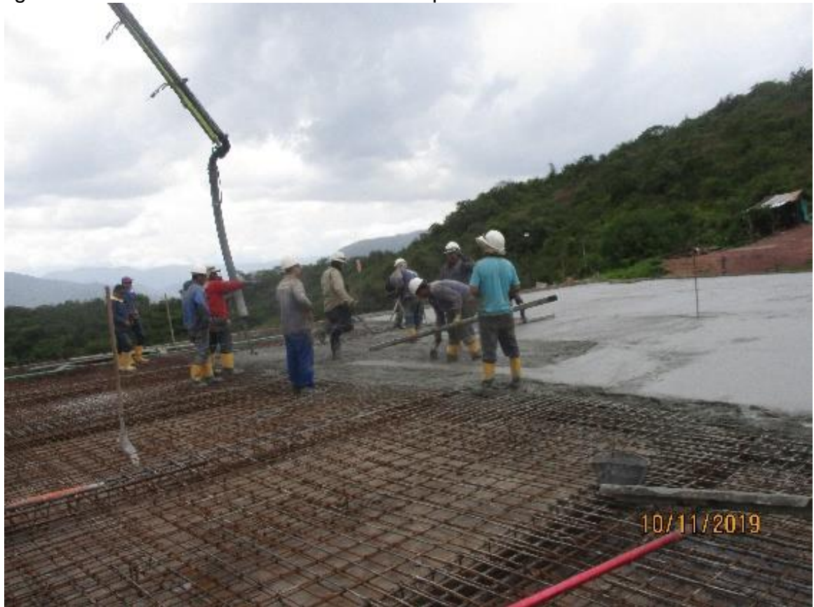
Figura 16 Vaciado de concreto cubierta tanque de almacenamiento
