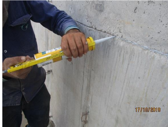
Figura 14 Instalación de Sika Flex 1a plus
