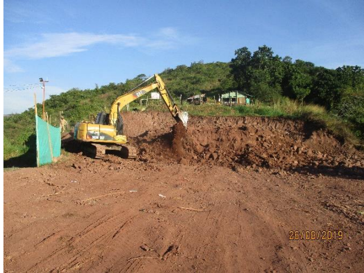
Figura 3 Excavación tanque de almacenamiento
