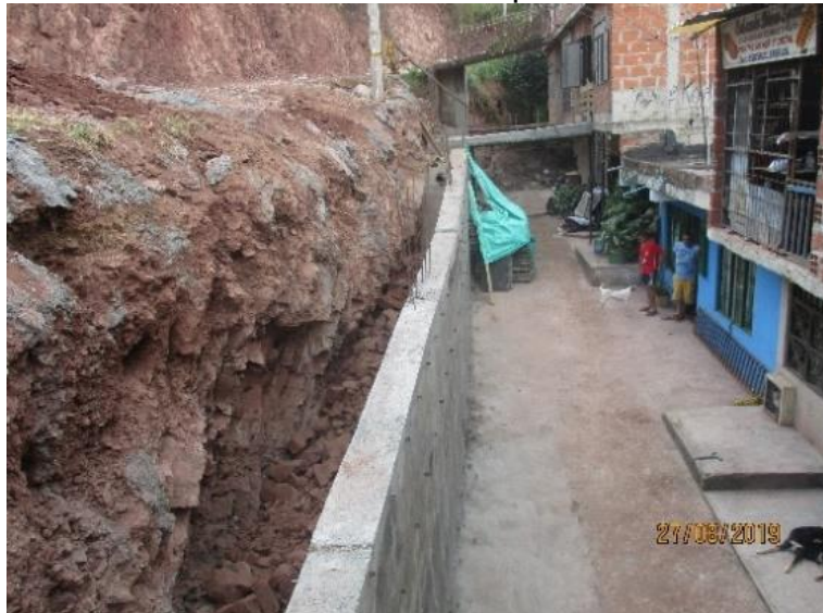
Figura 20 Muro de contención en concreto ciclópeo
