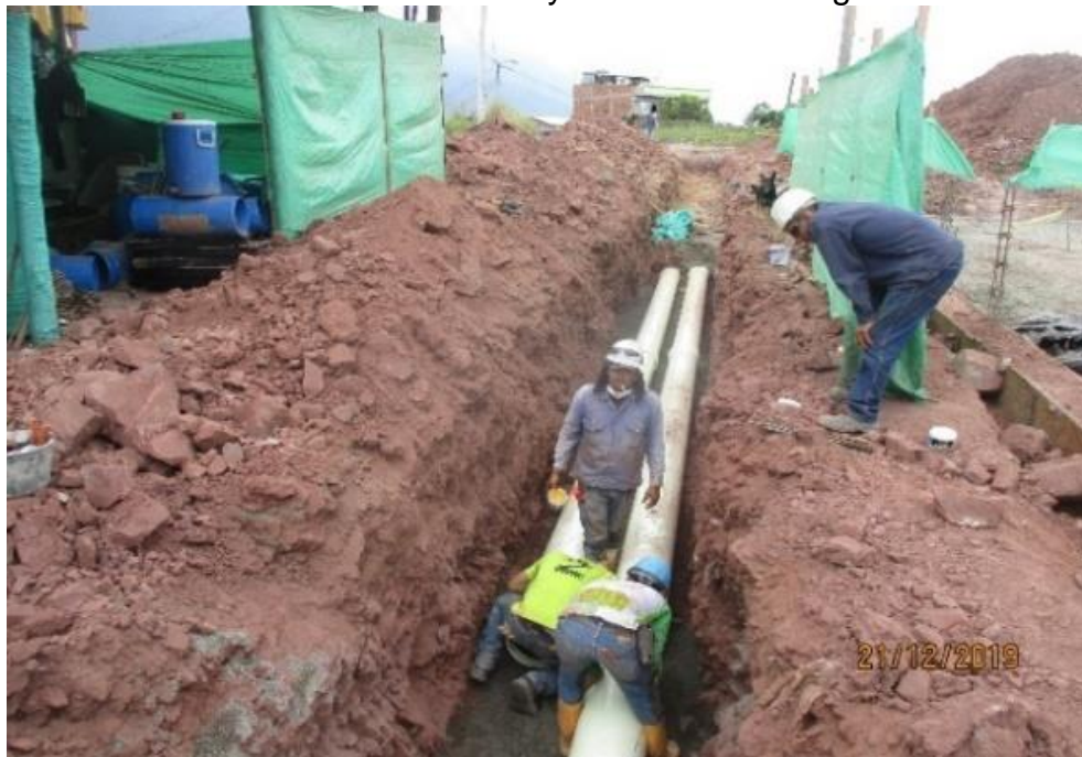
Figura 24 Instalación Red de conducción y distribución de agua
