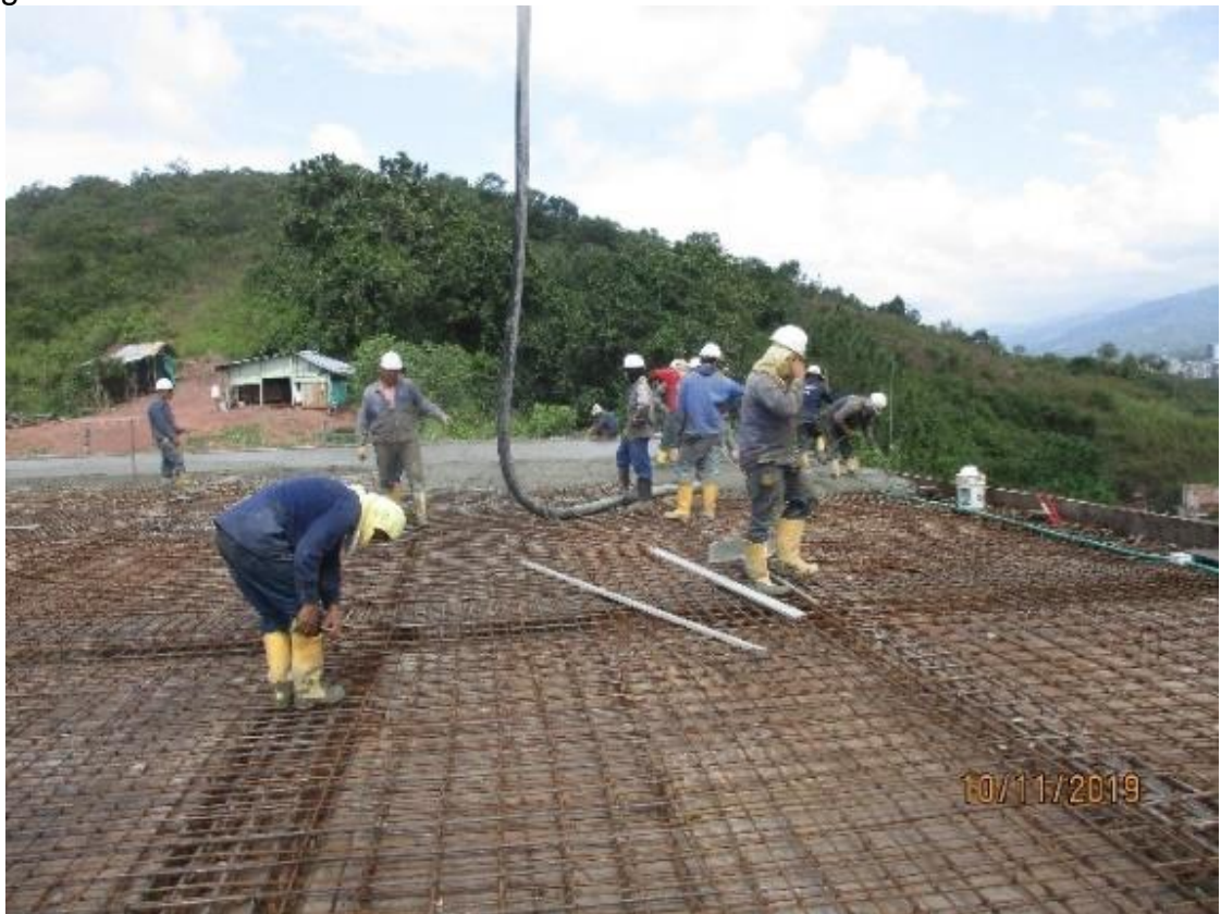
Figura 39 Actividad de vaciado de concreto
