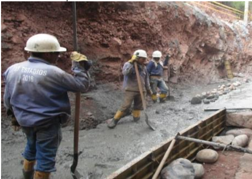
Figura 35 Fundida de zarpa muro calle 11-11a
