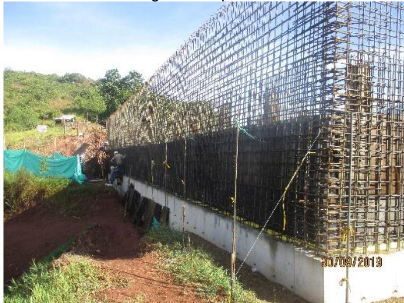
Figura 12 Colocación de acero segunda etapa del muro
