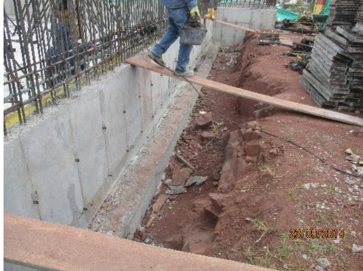
Figura 10 Primera etapa de construcción del muro del tanque de almacenamiento
