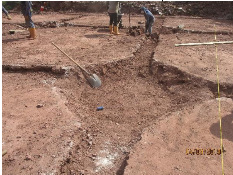
Figura 4 Excavación manual de la cimentación tanque de almacenamiento
