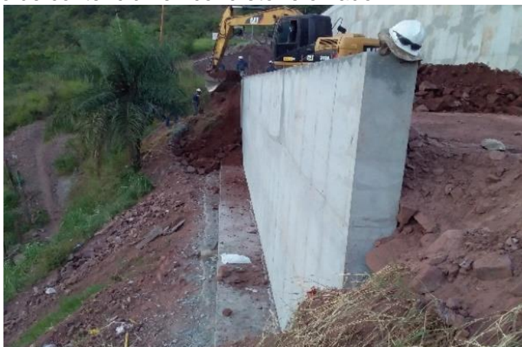
Figura 30 Muro de contención en concreto reforzado
