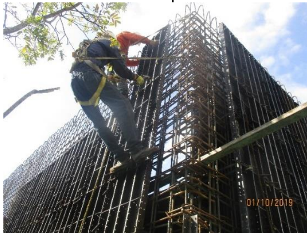
Figura 38 Actividad de encofrado muro tanque de almacenamiento
