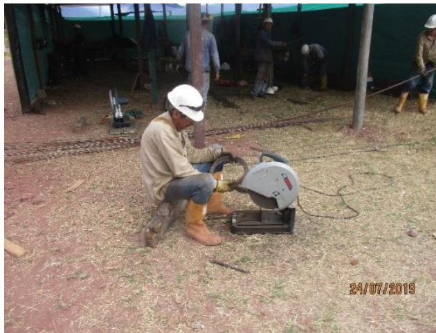
Figura 37 Actividad de corte de alambre
