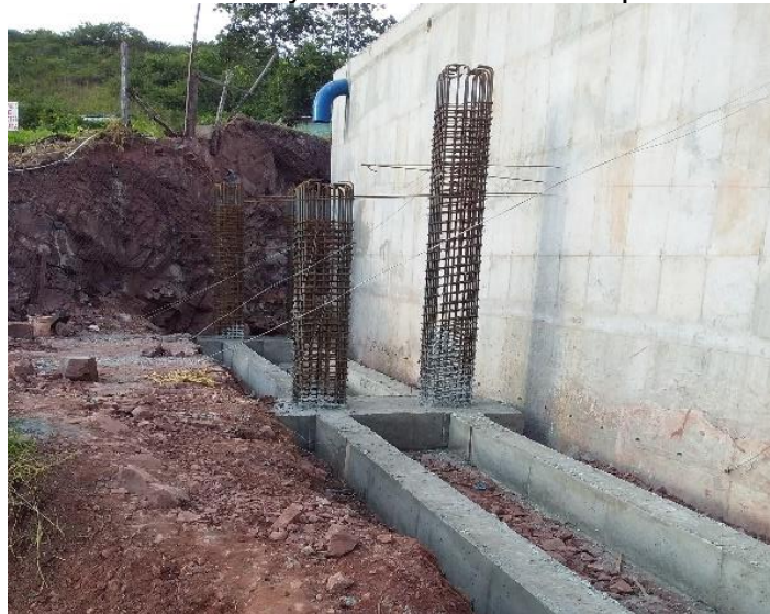
Figura 28 Sistema de cimentación y columnas de la rampa de acceso
