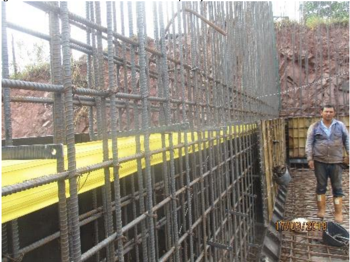
Figura 9 Instalación de cinta de PVC v-15 para juntas frías
