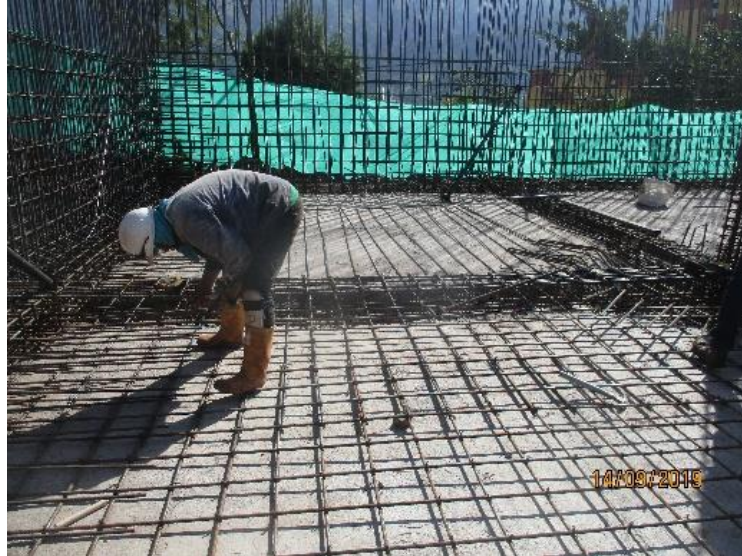
Figura 7 Colocación de acero de la placa de contrapiso
