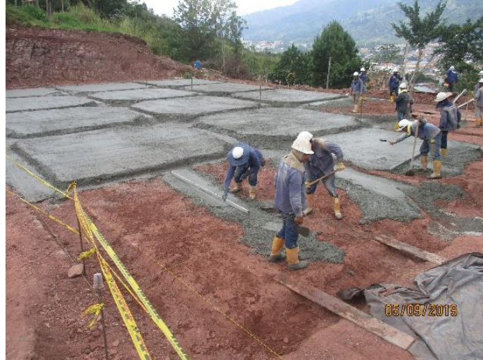
Figura 5 Vaciado de solado del tanque de almacenamiento
