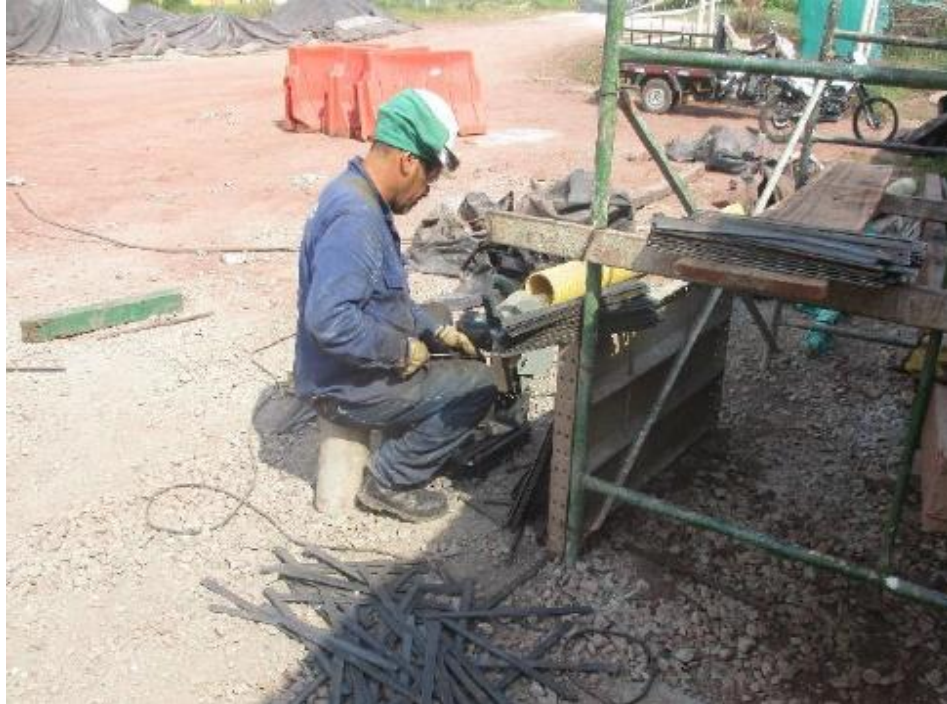
Figura 34 Corte de platinas
