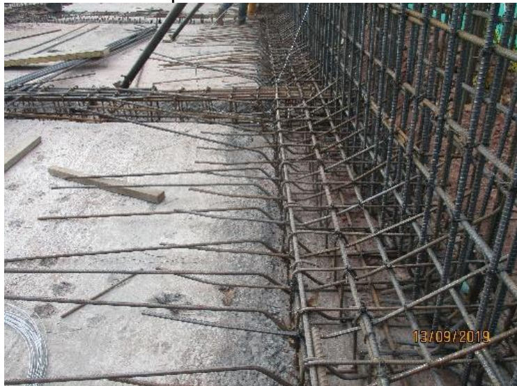
Figura 8 Refuerzo adicional tanque de almacenamiento
