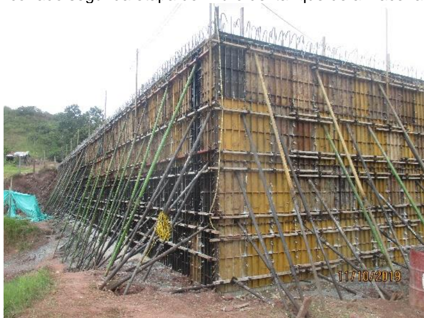
Figura 13 Encofrado segunda etapa del muro del tanque de almacenamiento
