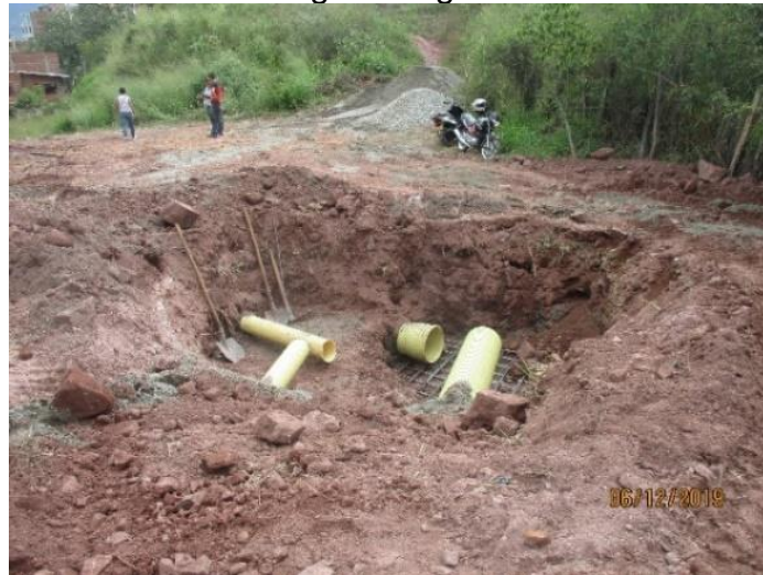
Figura 31 Red de alcantarillado de aguas negras
