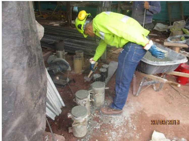
Figura 11 Toma de muestras de concreto
