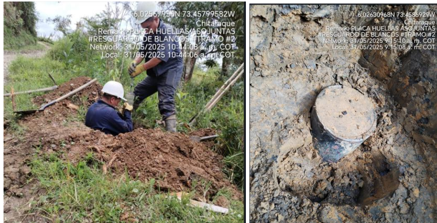
Figura 11 Registro fotográfico – Apiques y subrasante, Resguardo de Blancos (Chitaraque).
